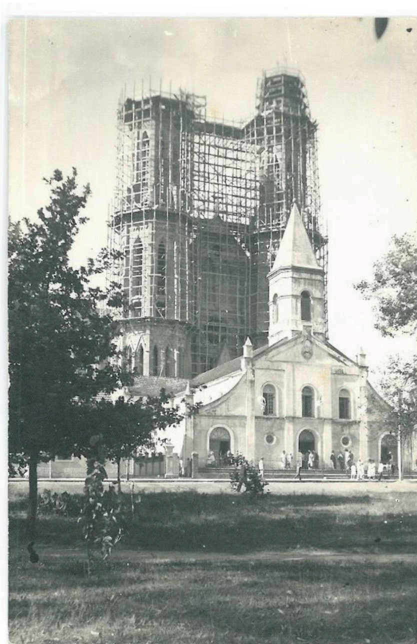
Figura 7 – Dimensão das matrizes de forma comparada (a antiga, à frente, e a nova, no fundo ainda com os andaimes). Fotografia sem data. Fonte: Arquivo Ronaldo Wink.
