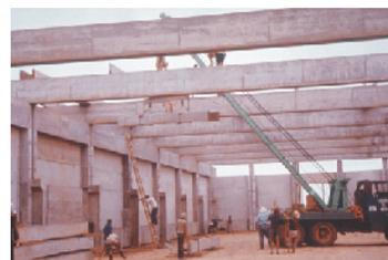
Fig. 151: Refinaria Alberto Pasqualini, montagem da estrutura pré-fabricada das oficinas e almoxarifados.
