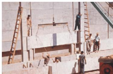
Fig. 148: Refinaria Alberto Pasqualini, montagem dos painéis-paredes.
