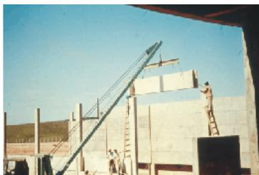
Fig. 147: Refinaria Alberto Pasqualini, montagem dos painéis-paredes.
