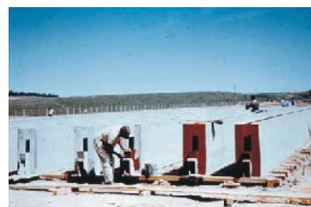
Fig. 152: Refinaria Alberto Pasqualini, concretagem das vigas-calhas.
