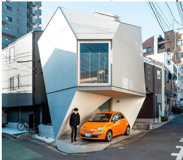
Figura 10 – A Mineral House , localizada no Japão
