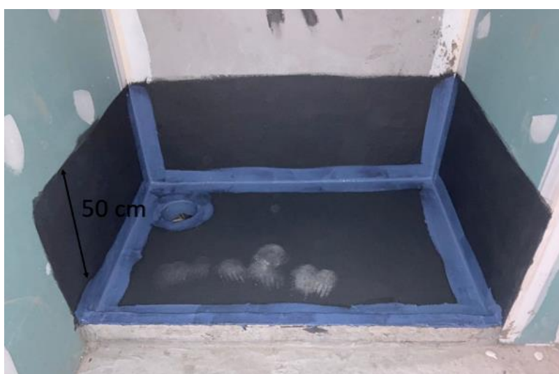
Figura 30 – Primeira demão do impermeabilizante acrílico com reforço nos cantos e ralos
