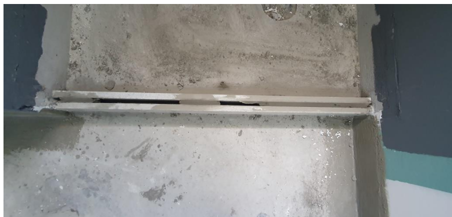
Figura 19 – Colocação da segunda mureta
