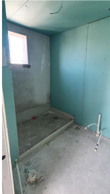
Figura 16 – Instalações hidráulicas e placas de gesso acartonado concluídas
