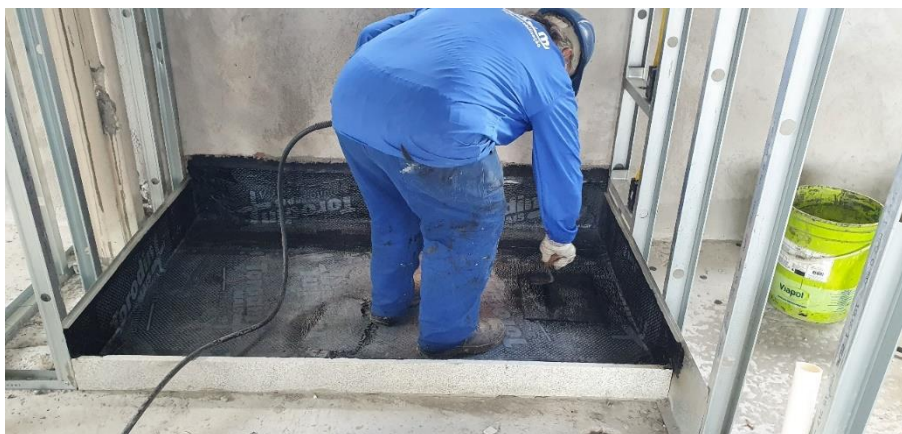
Figura 12 – Aplicação da manta asfáltica e vedação do ralo
