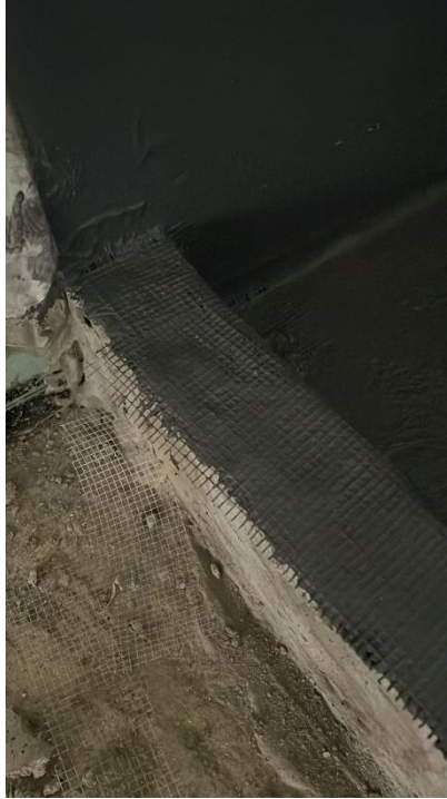
Figura 35 – Ponto crítico, mureta, com tela de poliéster e segunda demão de membrana acrílica
