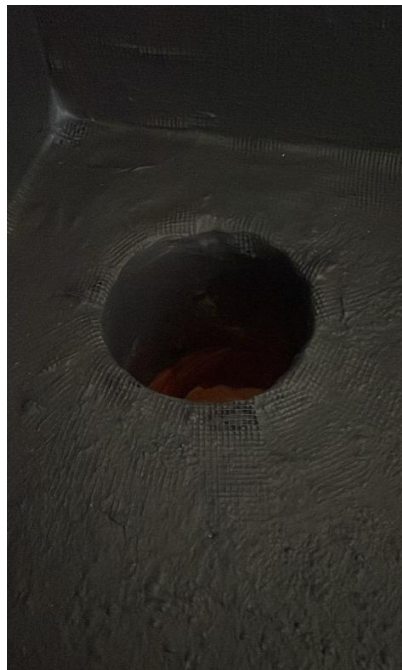
Figura 36 – Ponto crítico, ralo, com tela de poliéster e segunda demão de membrana acrílica
