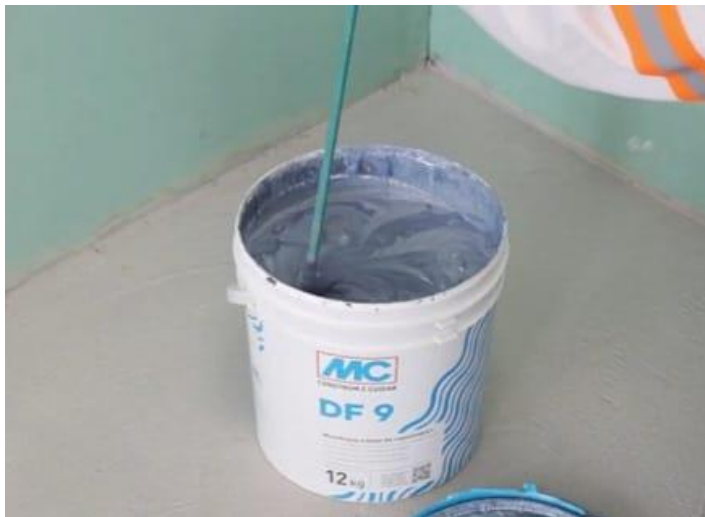
Figura 29 – Homogeneização da membrana acrílica
