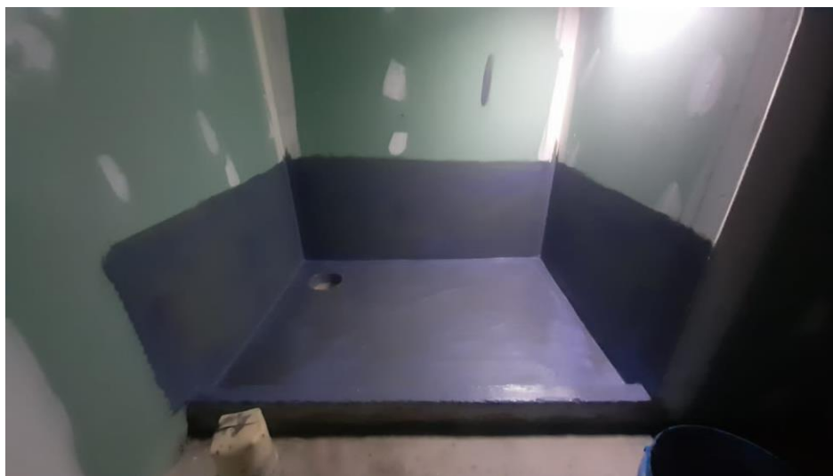
Figura 34 – Aplicação da segunda demão da membrana acrílica
