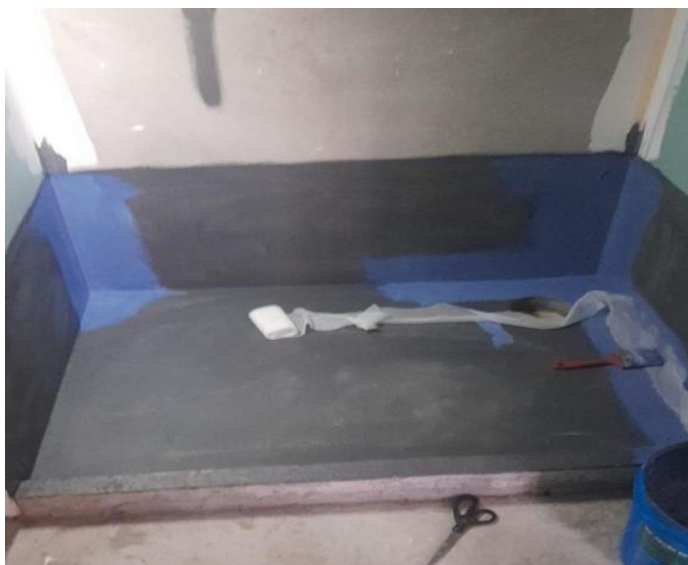
Figura 31 – Aplicação de tela de poliéster nos cantos
