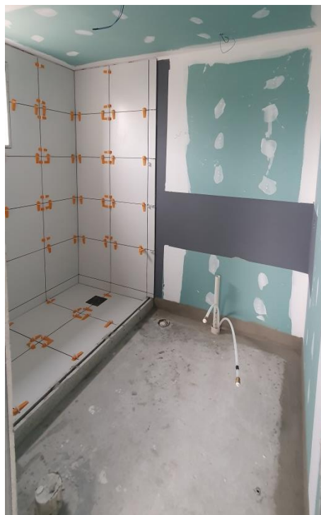
Figura 20 - Box com revestimento cerâmico e impermeabilização nas demais áreas do banheiro
