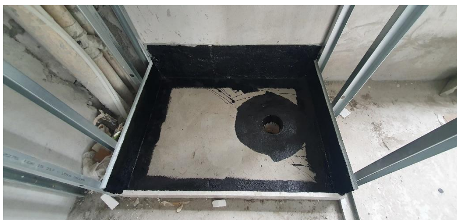
Figura 7 – Box com a primeira pedra colocada e imprimado
