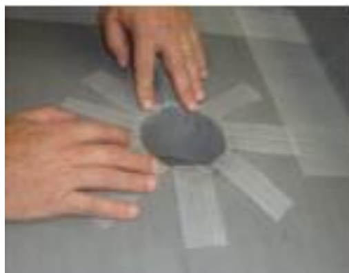
Figura 32 – Aplicação de tela de poliéster no ralo
