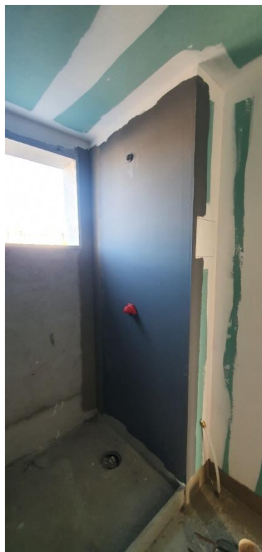
Figura 18 – Instalações hidráulicas e placas de gesso acartonado concluídas
