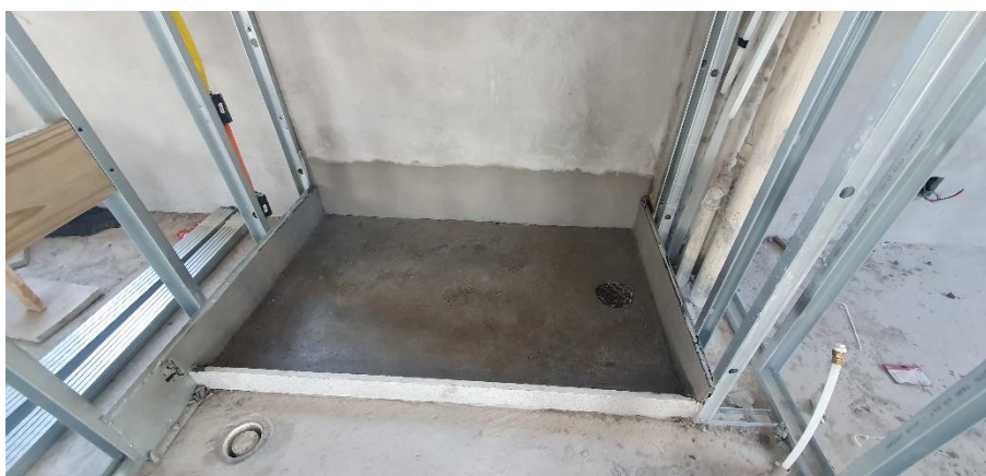
Figura 15 – Box impermeabilizado com a proteção mecânica e rodapés revestidos
