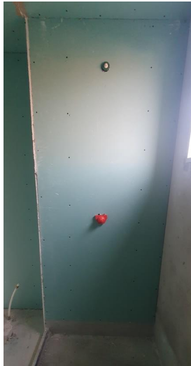
Figura 17 – Instalações hidráulicas e placas de gesso acartonado concluídas
