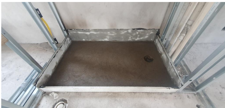
Figura 14 – Box impermeabilizado com a proteção mecânica e rodapés chapiscados
