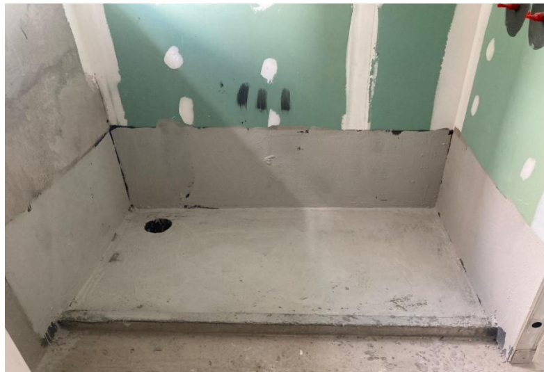
Figura 41 – Massa de aderência aplicada
