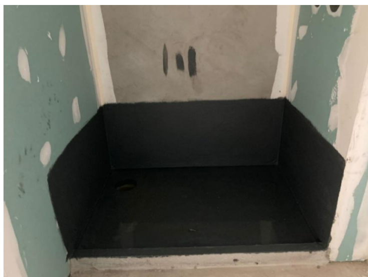
Figura 40 – Teste de estanqueidade em andamento
