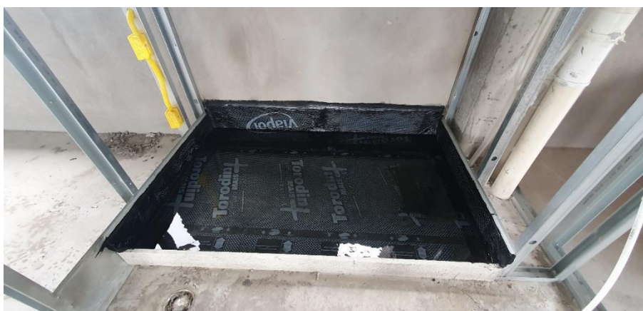
Figura 13 – Teste de estanqueidade
