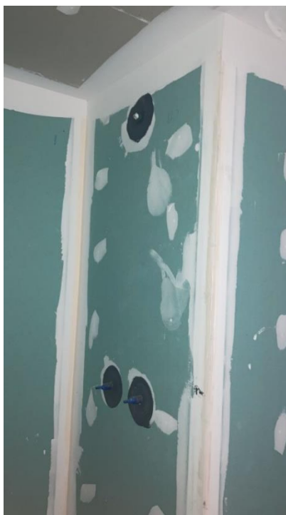
Figura 42 – Pontos hidráulicos impermeabilizados
