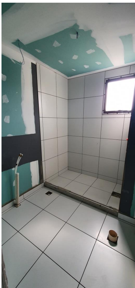
Figura 21 – Box com impermeabilização e revestimento cerâmico finalizado
