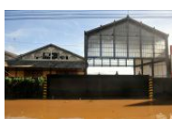
O sistema de proteção contra inundações de Porto Alegre
