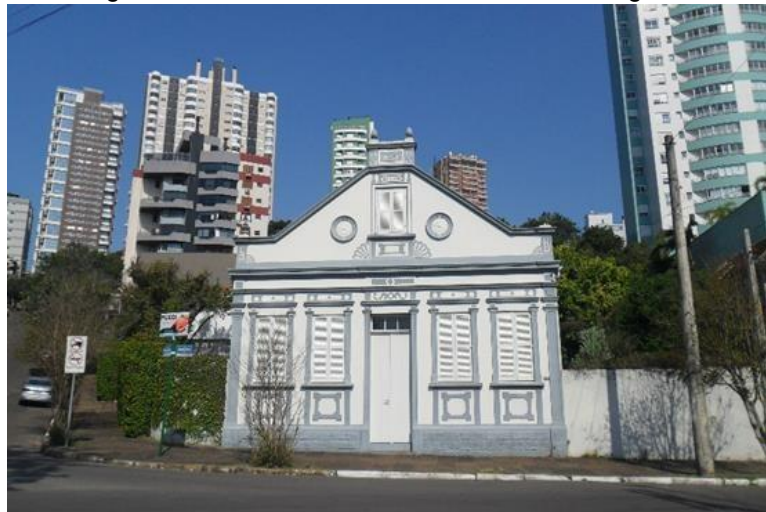
Figura 8: Rua General Osório – Novo Hamburgo
