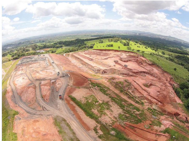
Figura 20 - Central de tratamento de resíduos de São Leopoldo.
