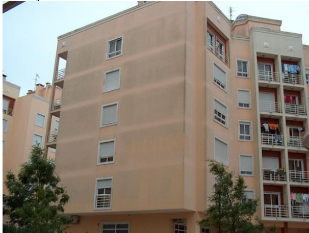
Figura 10 – Fantômes: visualização dos blocos da alvenaria e a estrutura através do revestimento da fachada
