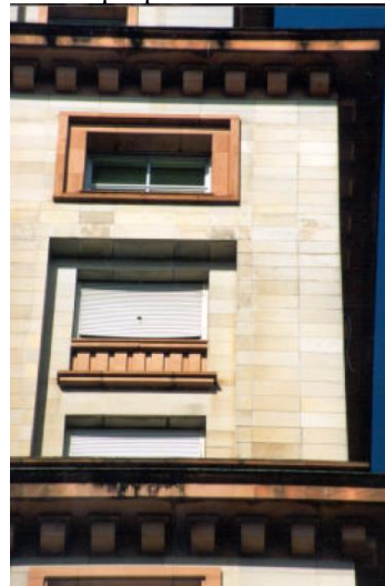
Figura 54 - Molduras horizontais que possibilitam o descolamento da água escorrida
