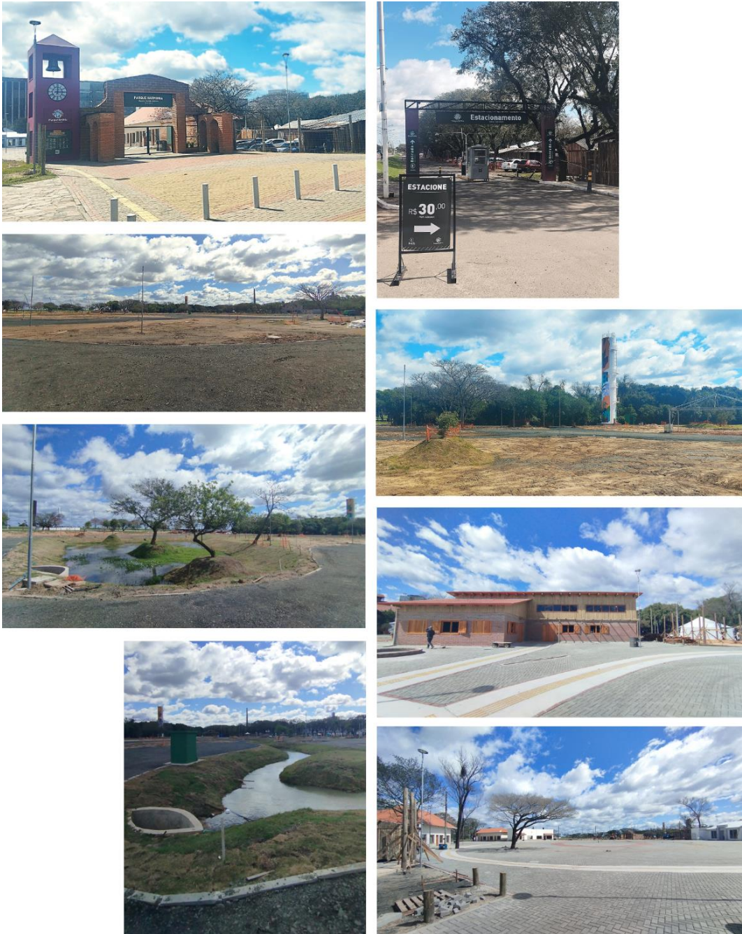
Figura 17: Obras em execução no Parque Harmonia em agosto de 2024.
