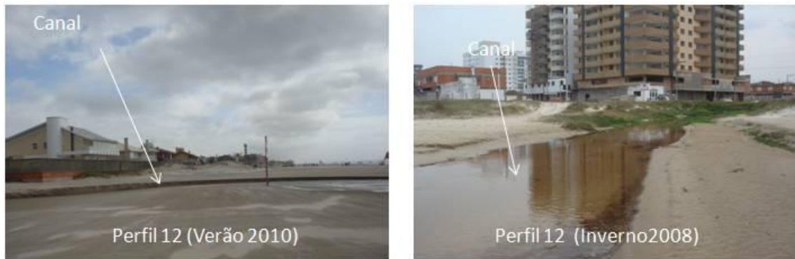
Figura 29: Desembocadura de canal presente no perfil 12 (Fonte: arquivo pessoal).
