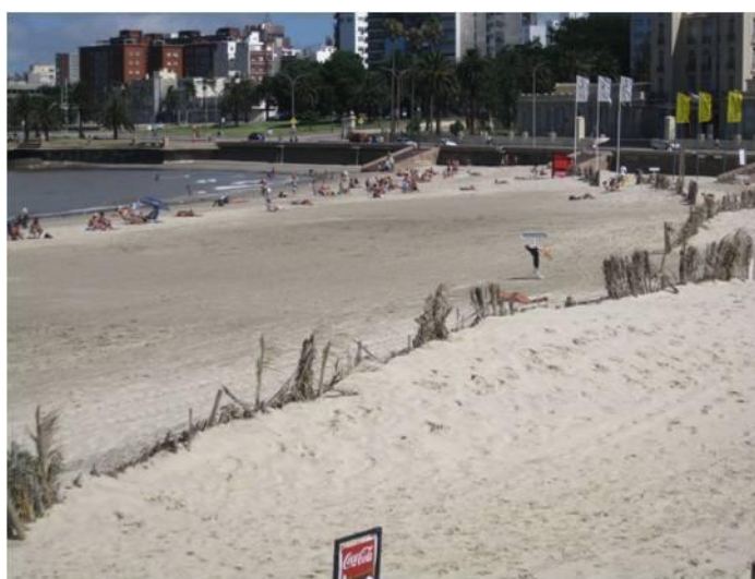
Figura 37: Implantação de cercados para retenção de areia e geração de dunas, em Montevideo- Uruguai (Foto: Arquivo pessoal).
