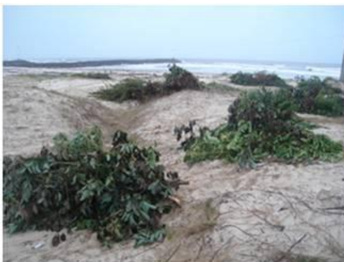
Figura 38: Uso de cobertura morta para a recomposição do perfil das dunas, Torres-RS (Fonte: arquivo pessoal).
