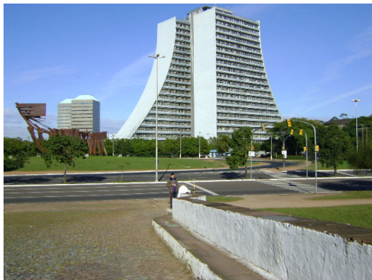
Fotografia 7: EDU PT 21 - 3/6/2010 - 09:21 - Canto da ponte dos Açorianos lado da Av. Loureiro da Silva
