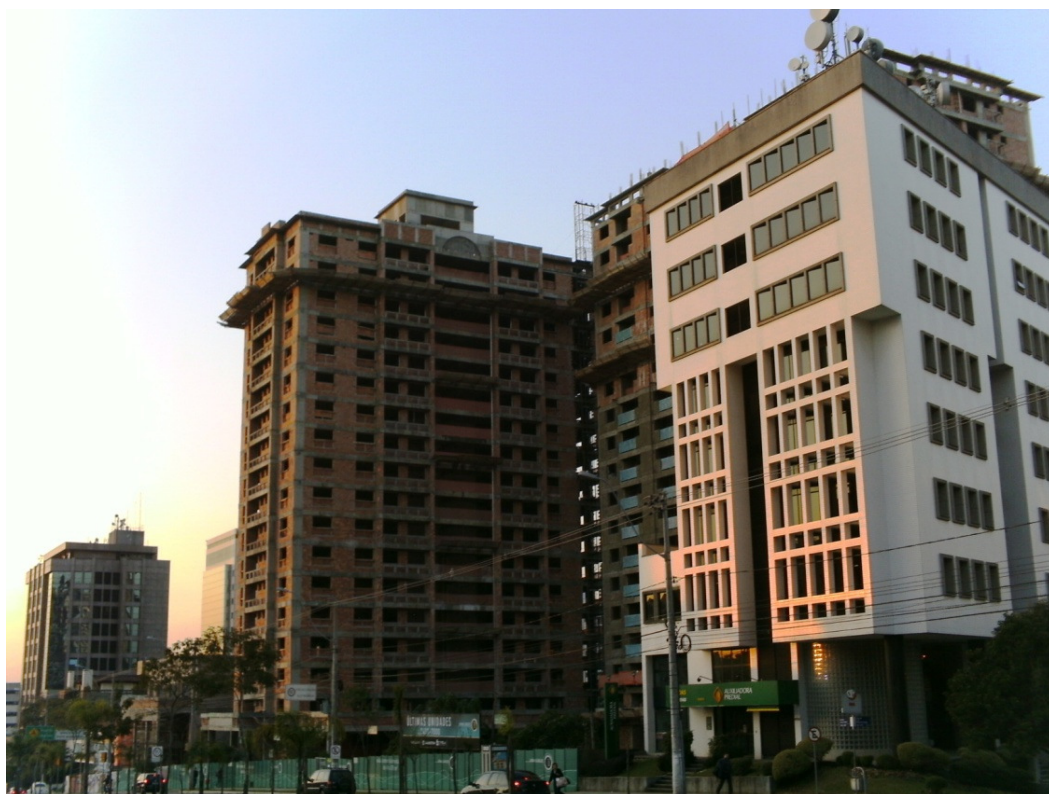
Foto 9: Construção de novos edifícios, cena comum no eixo da III Perimetral e seu entorno. (foto de Mariana Aita, 18/08/2010)
