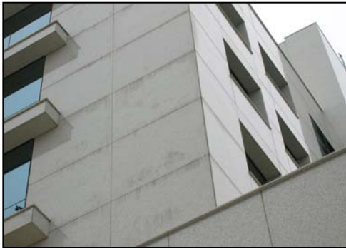
Figura 9: fachada revestida em granito branco Himalaia – Porto Alegre, RS
