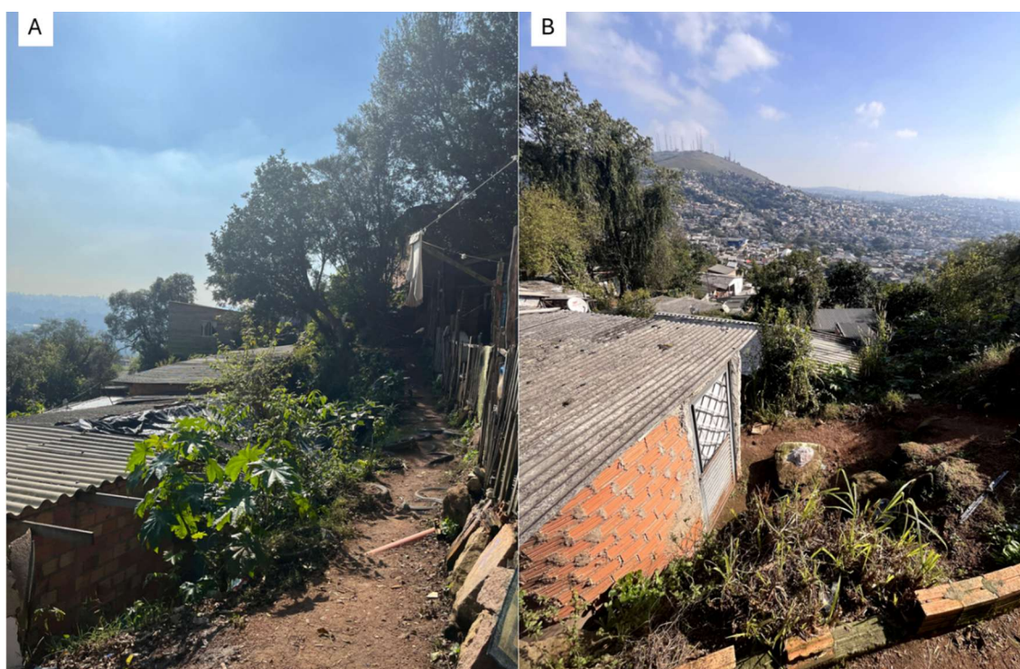
Figura 20: Vertentes côncavas nas cabeceiras de afluente do Arroio Moinho, no Morro da Cruz. (A) Vista para as residências e aterramentos dispostos em anfiteatro, acompanhando a concavidade horizontal da cabeceira. (B) vista para a porção inferior da vertente côncava, com alterações no relevo com patamares de aterros para a construção das residências. No plano de fundo da fotografia, topo convexo do Morro da Polícia e encostas retilíneas íngremes densamente ocupadas por NUIs. Declividades decrescentes de encostas convexas na porção direita da fotografia, no sopé do Morro da Polícia. Fonte: do autor, jul. 2024.
