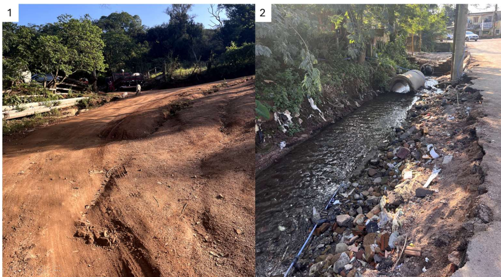
Figura 46: Geotecnoformas de denudação. (1) Sulco erosivo em estrada não pavimentada próxima ao Arroio Moinho. (2) Pavimento asfáltico parcialmente destruído após enxurrada. Fonte: do autor, jul. 2024.
