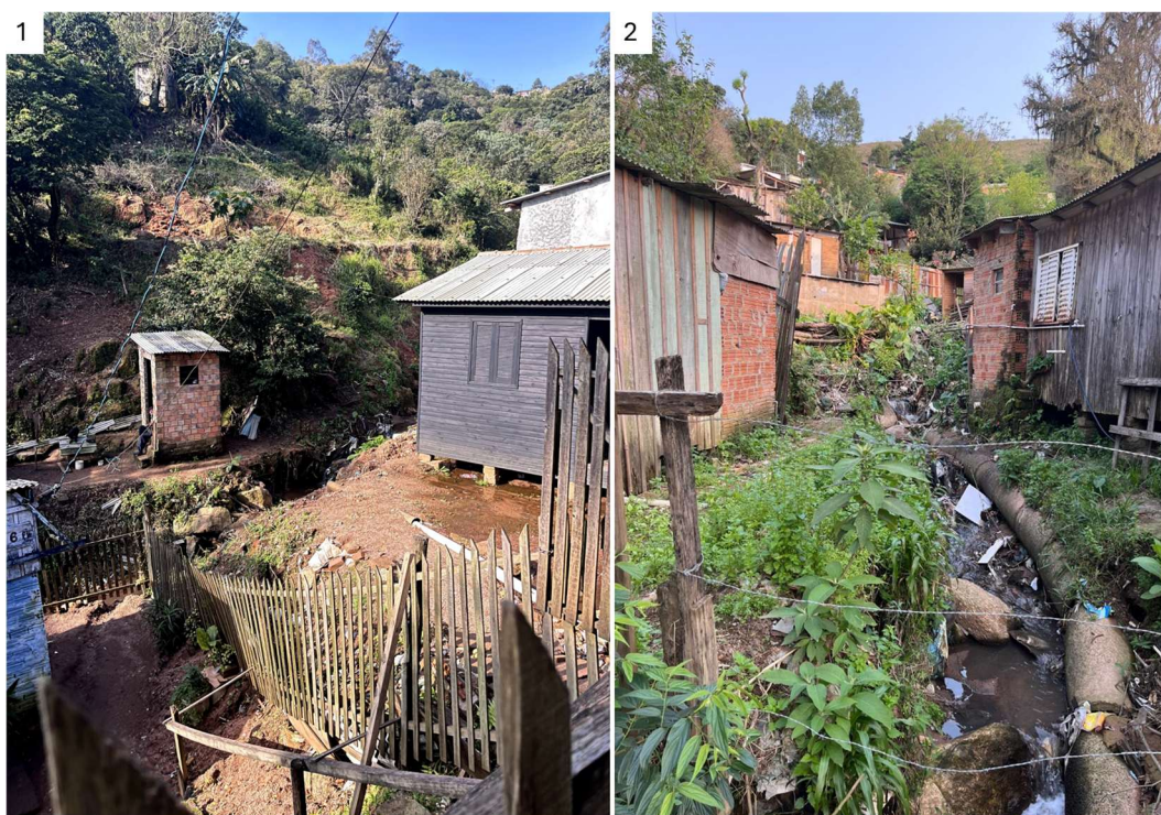
Figura 44: Construções sobre terraços fluviais em afluentes do Arroio Moinho. (1) Casas sobre terraço fluvial, destaque aos encanamentos que descartam esgoto doméstico diretamente no curso d'água. Percebe-se a existência de processos erosivos na encosta íngreme ao fundo, provenientes do escoamento superficial. (2) Moradias precárias sobre terraço fluvial. Destaca-se a existência de depósitos tecnogênicos em ambos os locais, evidenciando a influência humana na constituição dos materiais que acabam por reduzir a qualidade da água. Fonte: do autor, out. 2024.
