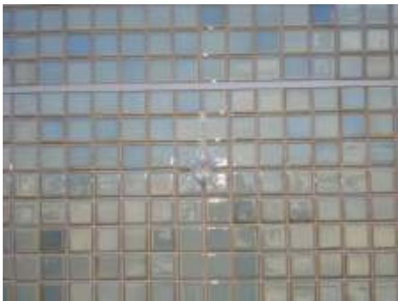
Figura C7: juntas Obra 6 sem sinais de envelhecimento e permeabilidade de água
