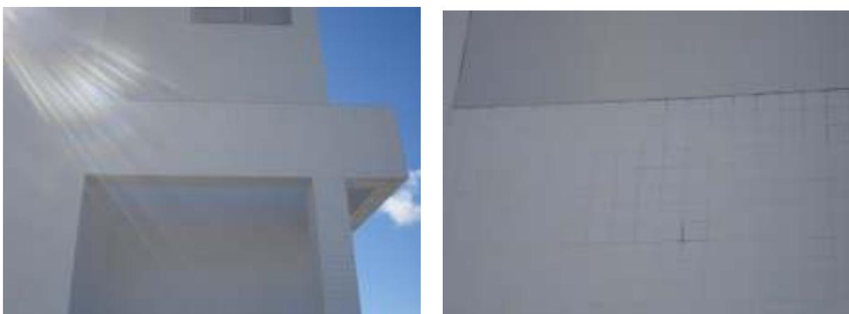
Figura C12: umidade nas juntas – bolor no rejunte
