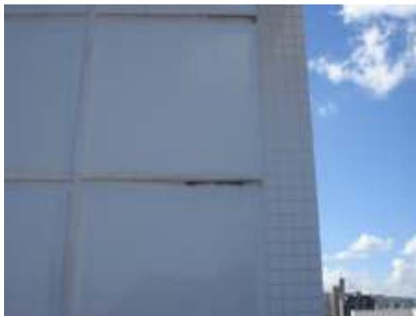
Figura C13: falha no rejuntamento
