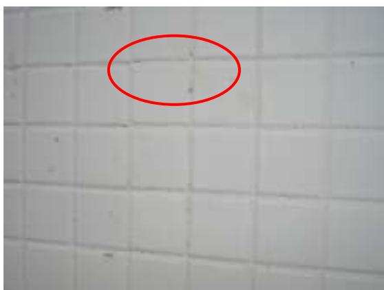
Figura C8: rejuntamento com muitas falhas
