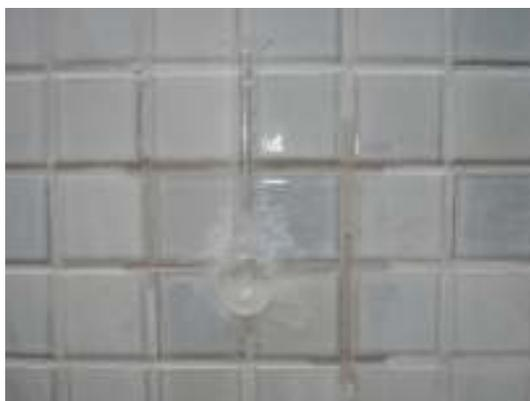
Figura C6: permeabilidade do rejunte – Obra 5
