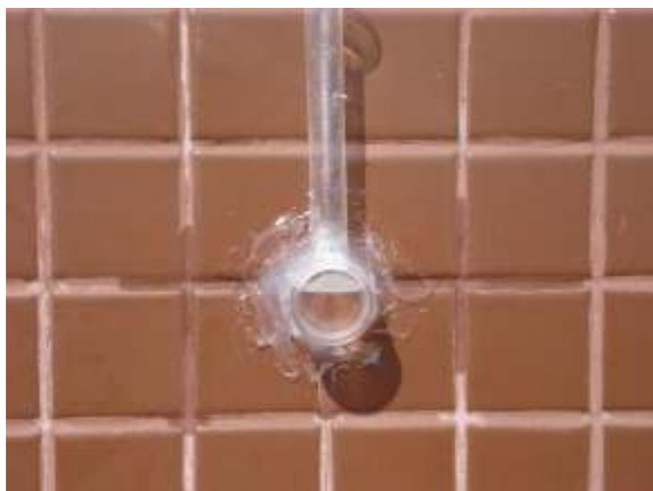
Figura C17: permeabilidade do rejunte – Obra 10 (pavimento superior)
