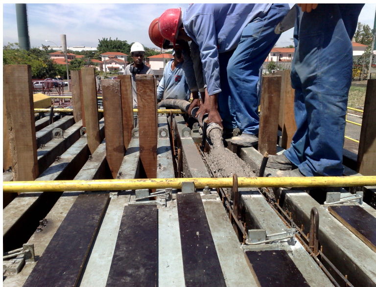
Figura 2: concretagem de uma bateria de painéis (trabalho não publicado 1 )
