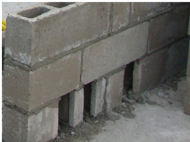
Figura 9: janelas de inspeção deixadas ao pé da parede para limpeza dos pontos a serem grauteados
