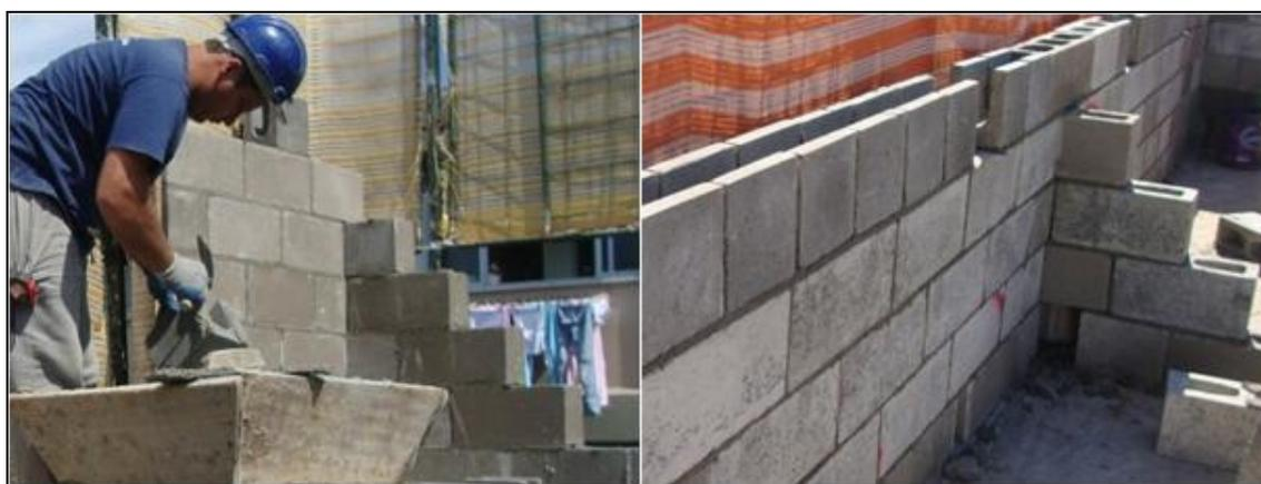
Figura 20: conformação das esperas para paredes adjacentes em escadinha
