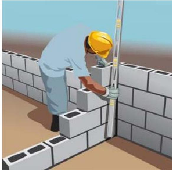
Figura 8: utilização de régua técnica para verificações de prumo, nível e planicidade durante a execução (ASSOCIAÇÃO BRASILEIRA DE CIMENTO PORTLAND, [200-?b], p. 6)
