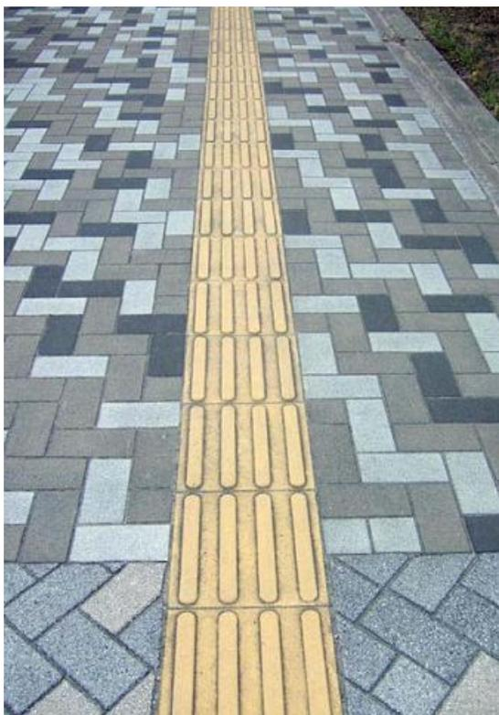
Figura 14: calçada com marcas em relevo (WRIGHT; HOOK, 2008, p. 539)
