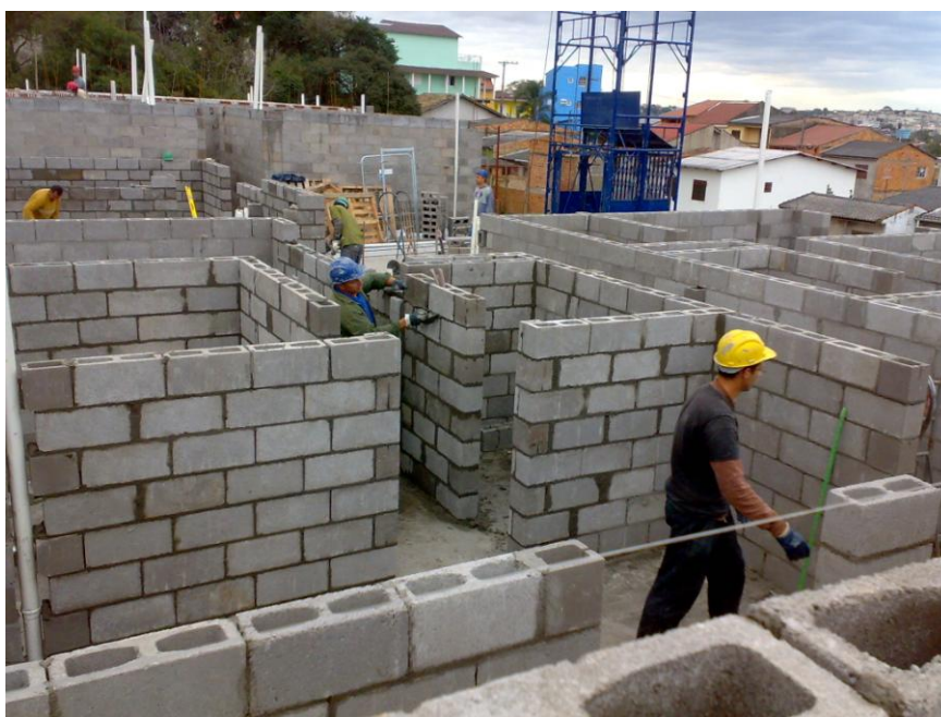
Figura 8: Auxílio de linhas para assentamento de blocos
