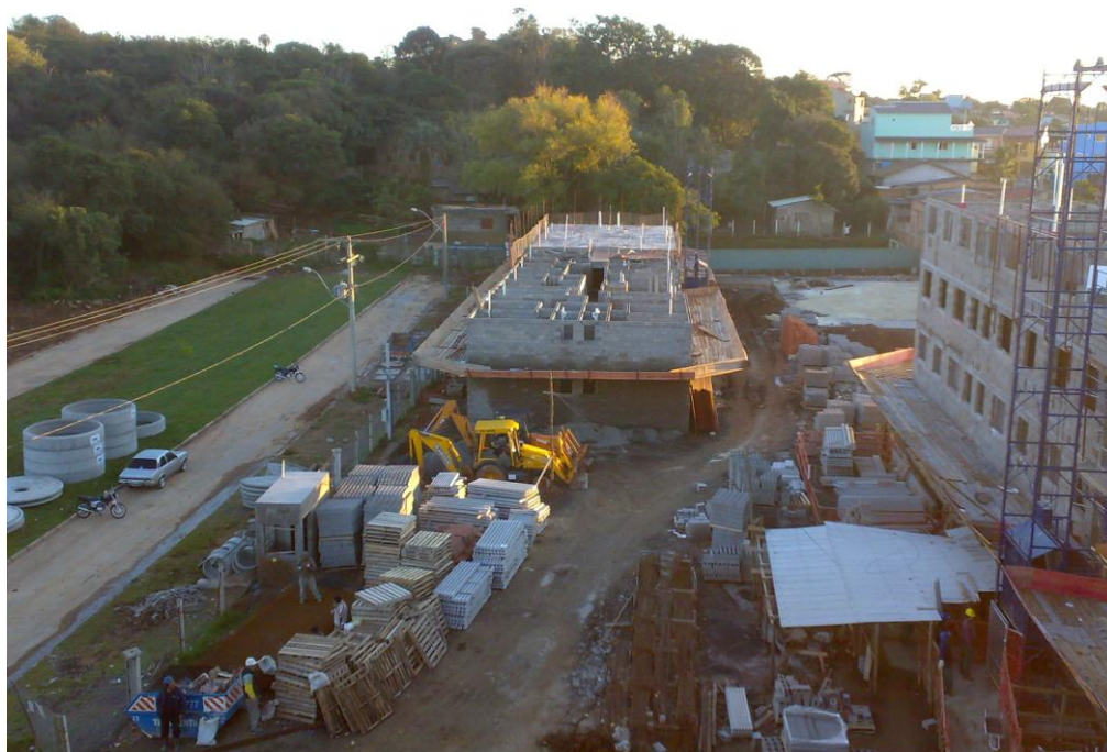
Figura 12: desorganização do canteiro
