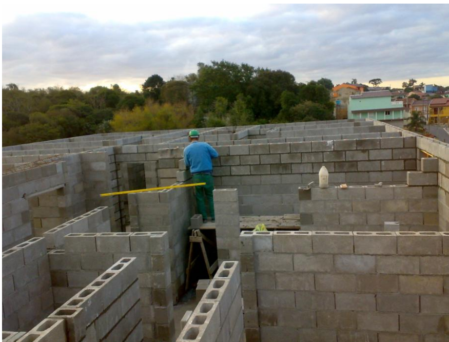
Figura 11: assentamento de dez fiadas de blocos sem o uso de andaime
