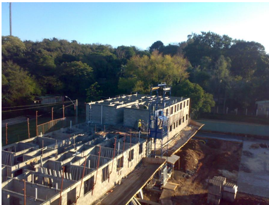
Figura 7: aspecto das asas da torre
