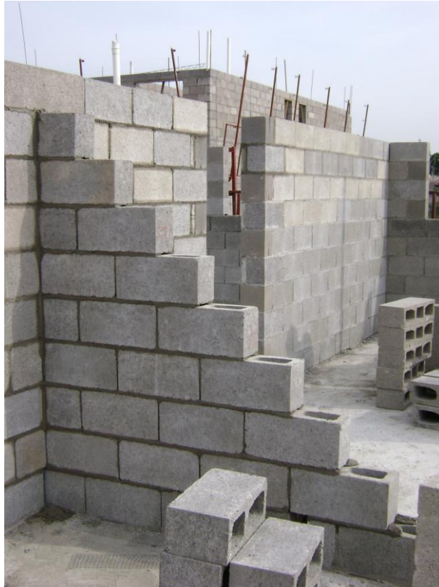
Figura 14: castelinho com área equivalente a cinco fiadas
