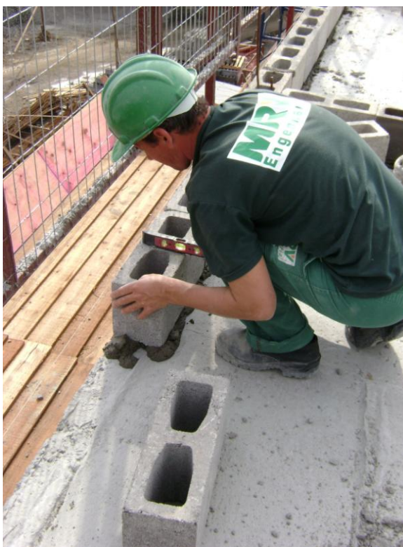
Figura 10: execução da marcação
