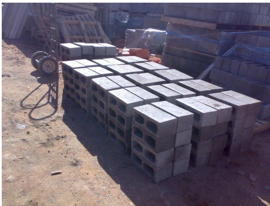
Figura 13: forma de organização de blocos para transporte com carrinho espeto
