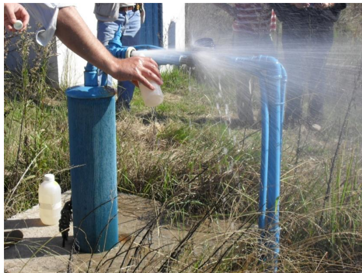
Figura 2 - Coleta de amostra de água na saída do poço.
