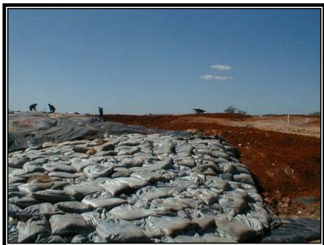
Figura 2: Célula para disposição de resíduos classe II, sem cobertura
