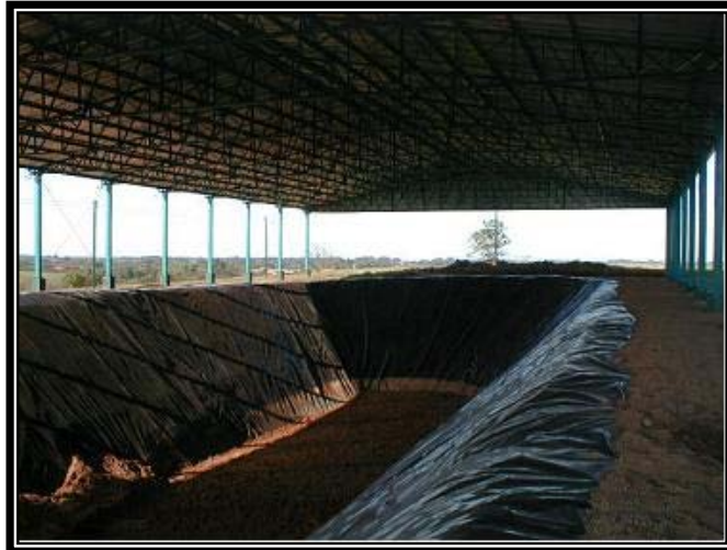
Figura 1: Célula para disposição de resíduos classe I, com cobertura
