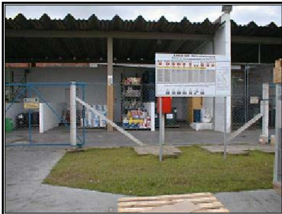
Figura 10: Área de inflamáveis e estocagem temporária de resíduos classe I
