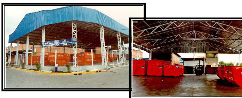
Figura 11: Área Temporária de Resíduos – ATR
