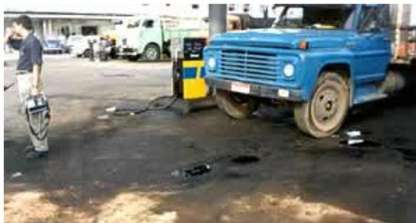
**Figura 3 – Contaminação por derrame superficial em pista de abastecimento não impermeabilizada.**
