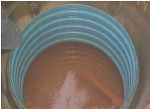
**Figura 10 – Presença de gasolina em câmara de acesso à boca de descarga**
