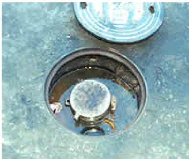
**Figura 5 – Câmara de calçada de boca de descarregamento contaminada por óleo diesel.**
