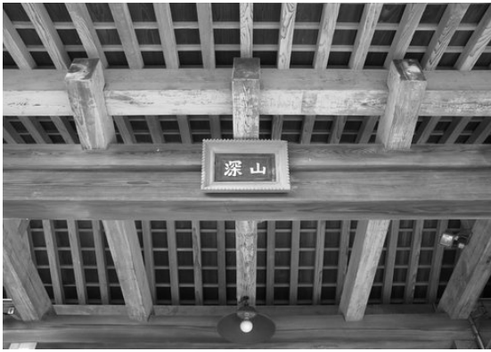
(a) Estrutura de madeira de um templo japonês
