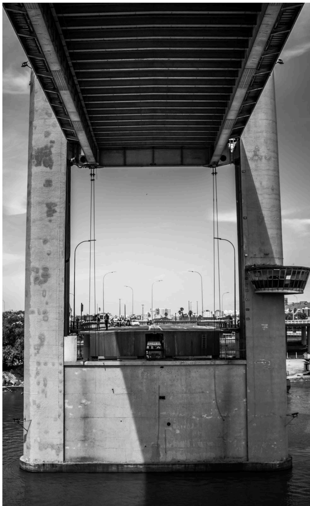
Figura 4 - Vão móvel, da ponte pra cá
