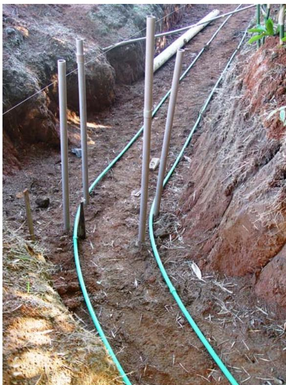
Figura 20: Tubulação d'água – recalque e retorno
