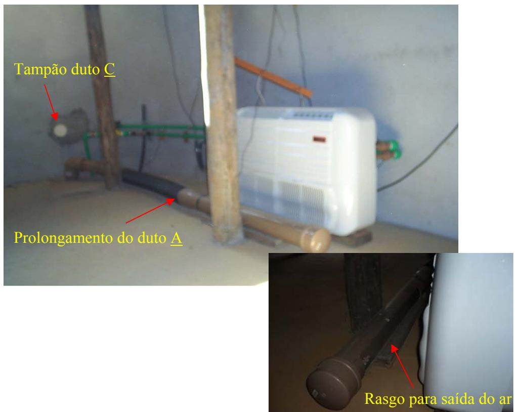
Figura 18: *Fan-coil* – instalação no Ambiente A
