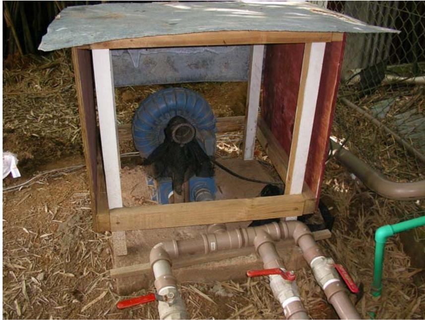
Figura 23: Ventilador – sucção protegida por filtro (tela)
