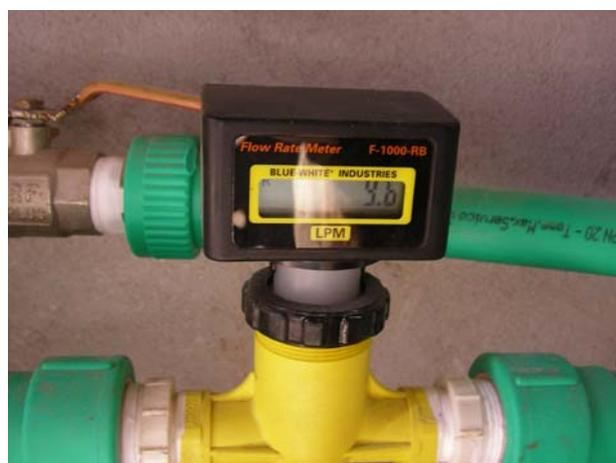
Figura 38: Rotâmetro de linha, usado no experimento
