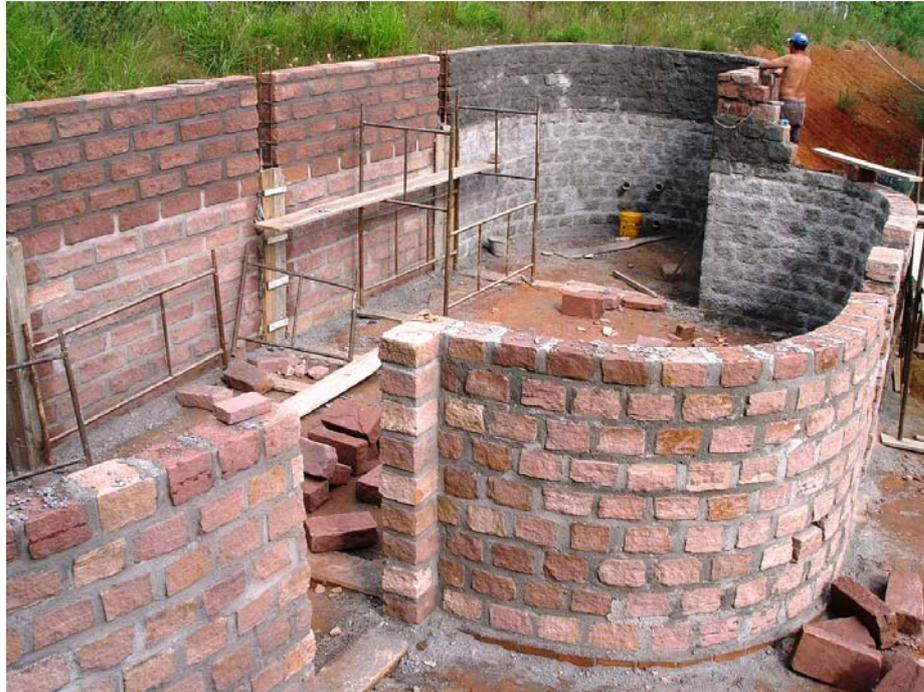
Figura 13: Casa ventura – execução das paredes
