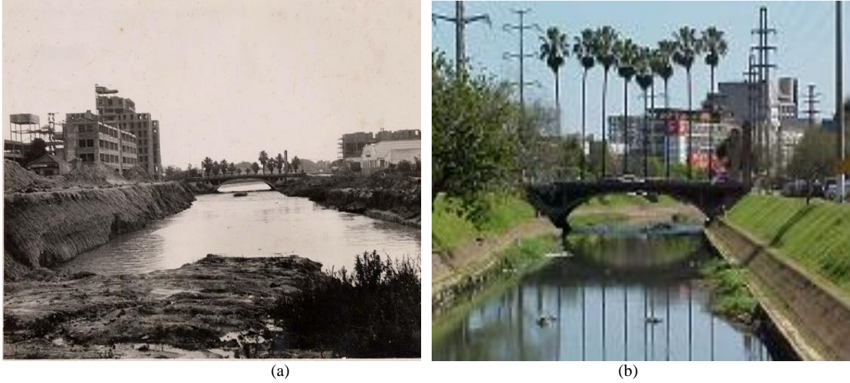
Figura 3.4: (a) Ponte da Av. João Pessoa durante obras de retificação (acervo Fototeca Sioma Breitman, Museu Joaquim José Felizardo) e (b) Ponte da Av. João Pessoa, após as obras de retificação.
