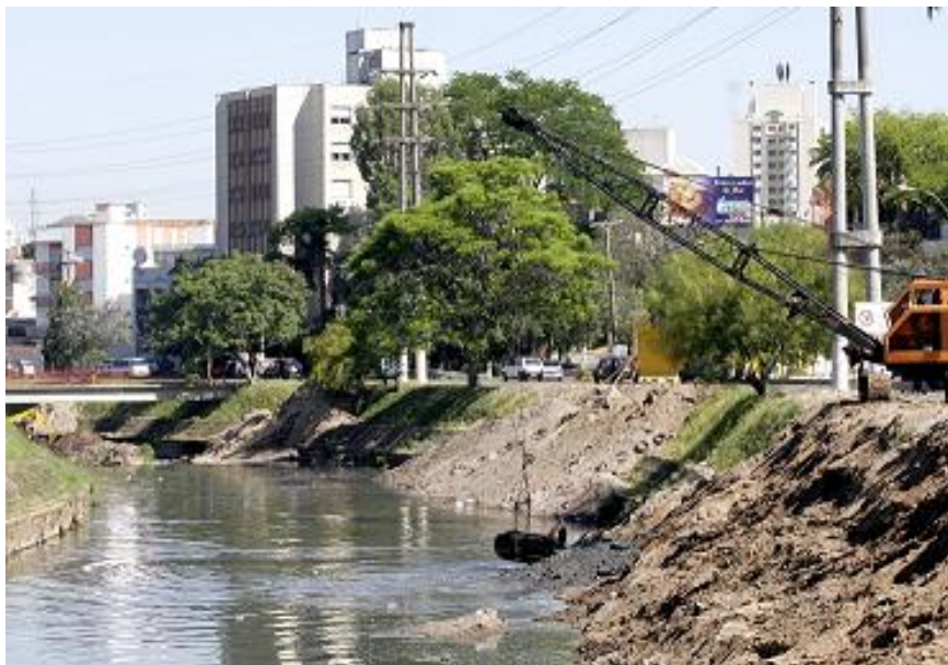
Figura 3.10: Draga recolhendo o sedimento acumulado na borda do arroio
