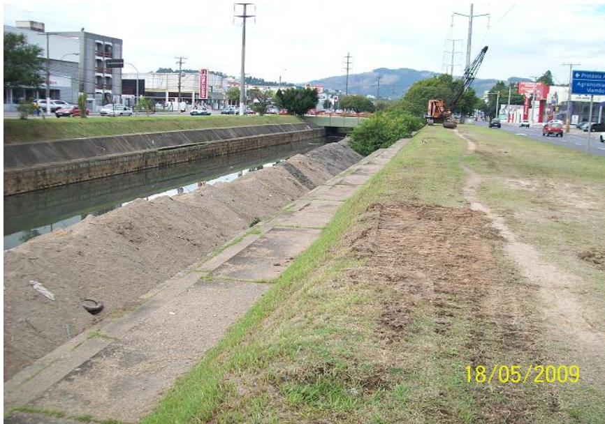
Figura 3.9: Sedimento acumulado na borda do arroio para secagem e posterior transporte
