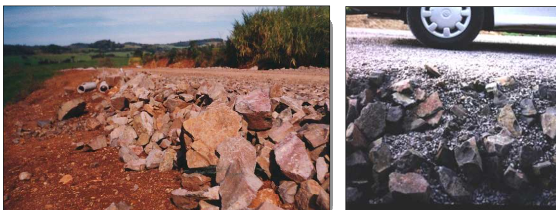
Figura 3.4: Detalhe da construção da rodovia
