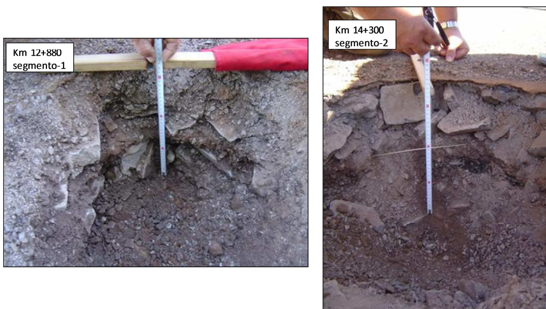
Figura 5.8: Trincheiras abertas na rodovia
