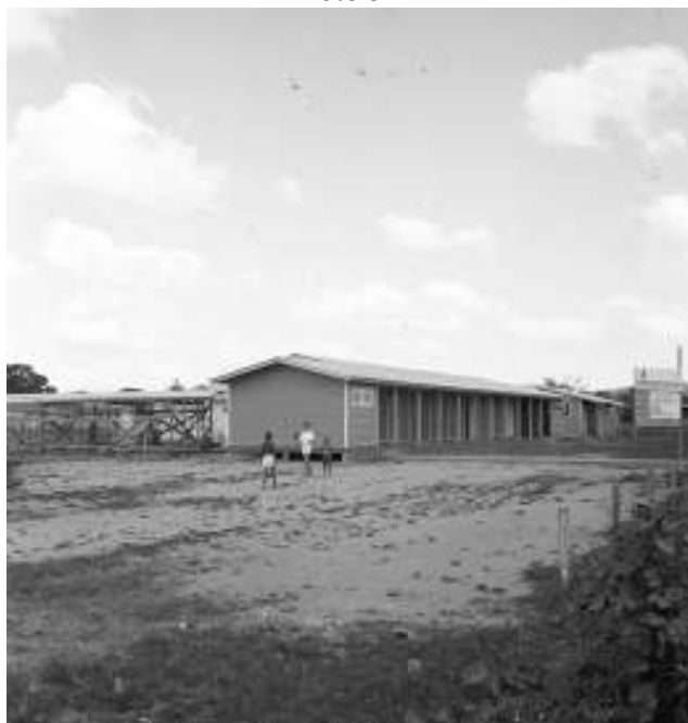
Construção de prédios de Grupos Escolares do Plano de Obras do Estado no Bairro Tristeza. 28/01/1960. (APP04M04732)
