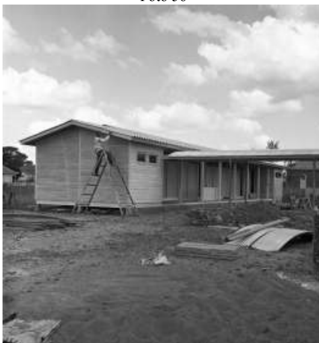
Construção de prédios de Grupos Escolares do Plano de Obras do Estado no Bairro Tristeza. 28/01/1960. (APP04M04741)
