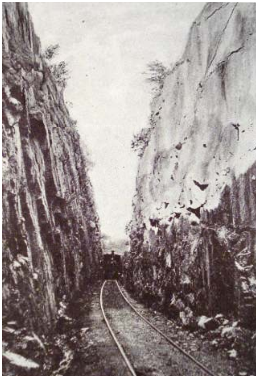
Fig. 2.15: Corte na rocha, no prolongamento da linha para a praia da Pedra Redonda, vendo-se uma locomotiva retornando da praia para a Tristeza. Fonte: DOMECCQ, Monte. O Estado do Rio Grande do Sul. 1916. Pg. 168.
