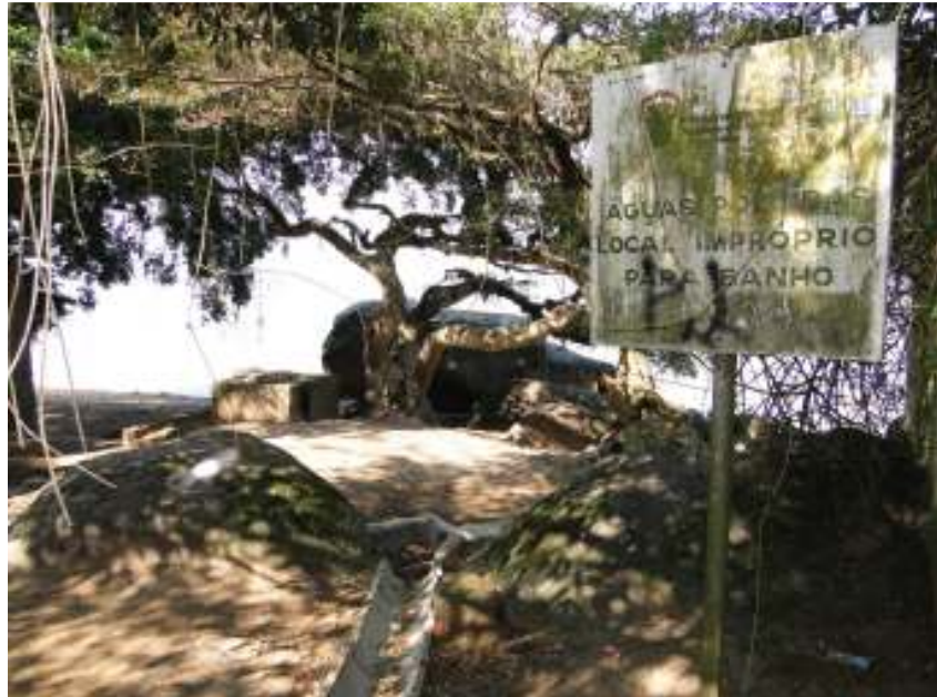
Fig. 3.61: Acesso para a praia da Pedra Redonda: sarjeta com esgoto a céu aberto e lixo, construção irregular sobre a via. Fonte: Foto do autor.
