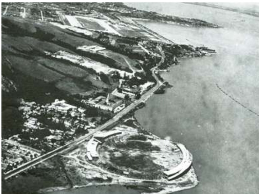
Fig. 3.24: O estádio de futebol sendo construído em aterro sobre o Guaíba, em meados da década de 1960. Na parte superior da foto pode-se ver o Hippódromo do Cristal, à direita a ponta do Dionísio e do Melo. Fonte: http://www.internacional.com.br/pagina.php?modulo=4&setor=29&secao=&subsecao=
