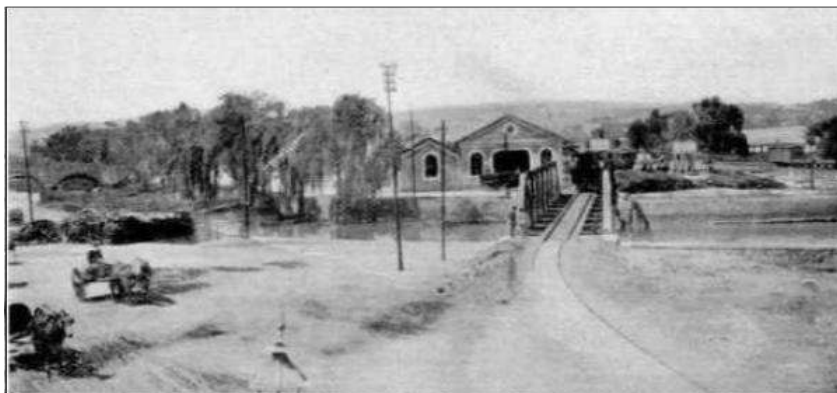
Fig. 2.32: A estação do Riacho e a ponte metálica da ferrovia em 1916. À esquerda a Ponte de Pedra.
