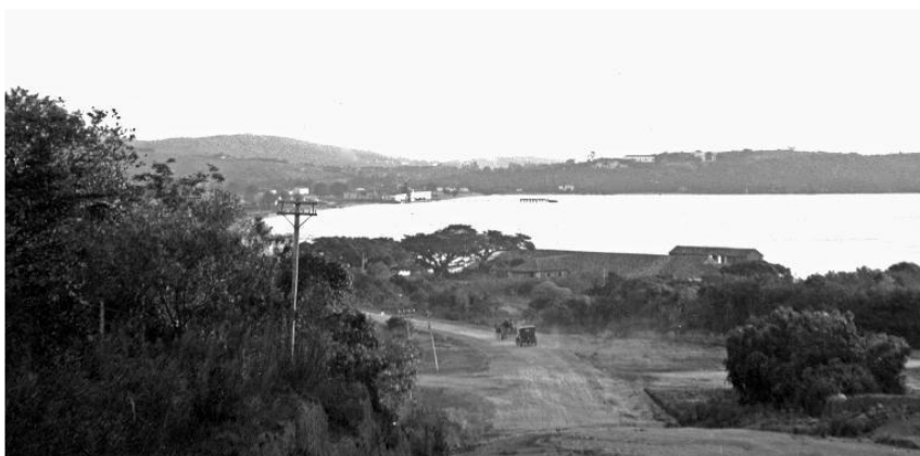
Fig. 2.50: Na direção oposta da figura 2.49, esta foto da década de 1920 mostra o novo acesso rodoviário, ainda sem pavimentação, na descida da “Lomba do Asseio”. O prédio na margem do Guaíba é o quartel da Brigada Militar.
