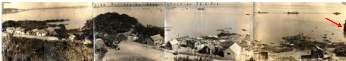
Fig. 3.19: Faixa pretendida pelo Estaleiro Só & Cia”, final da década de 1940. Observe-se que não havia mais trilhos da ferrovia, mas ainda permanecia – assinalado no extremo direito da foto – o trapiche para lançamento dos cubos sanitários.
