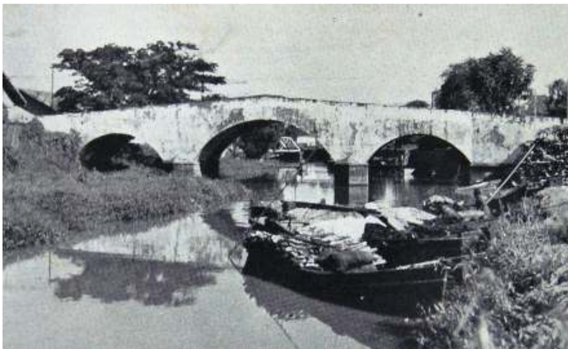
Ponte de Pedra sobre o Arroio Dilúvio, o Riacho, vendo-se atrás do arco central a ponte metálica da Ferrovia do Riacho.
