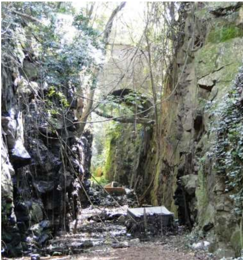
Fig. 3.63: Antiga passagem na rocha para a Pedra Redonda, completamente abandonada, está transformada em depósito de lixo. Ao fundo pode ser observada a ponte seca do acesso à Vila Conceição. Fonte: Foto do autor.
