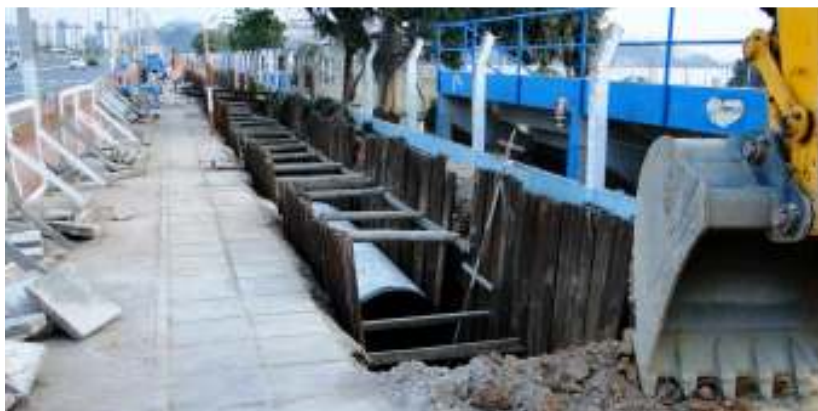
Fig. 3.86: A colocação do conduto para o esgoto sanitário prossegue na Av. Diário de Notícias.
