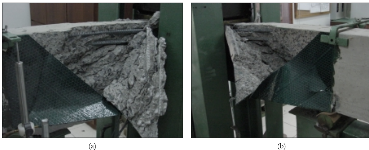
FIGURA 5-61 — Detalhe do modo de ruptura das vigas V14_A e V15_A
