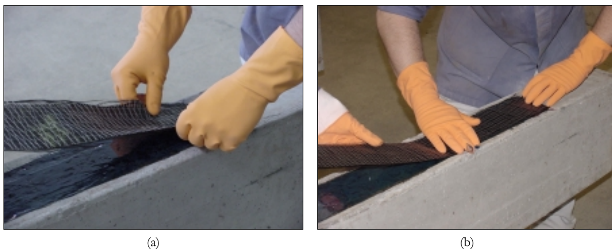
FIGURA 4-14 — Posicionamento da manta flexível
