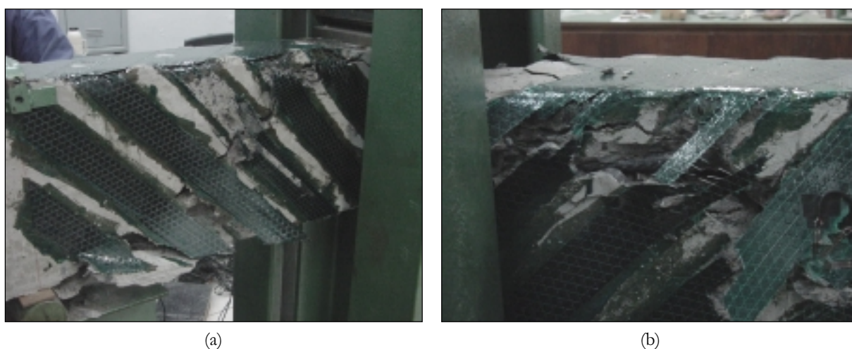
FIGURA 5-57 — Detalhe do modo de ruptura das vigas V19_A e V19_B
