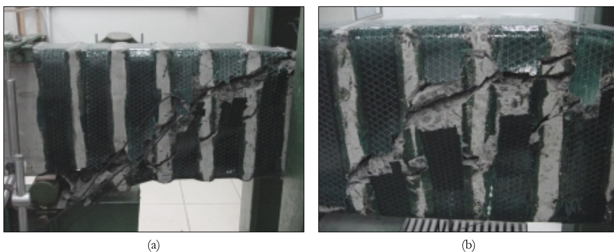
FIGURA 5-54 — Detalhe do modo de ruptura das vigas V12_A, V18_A e V20_A
