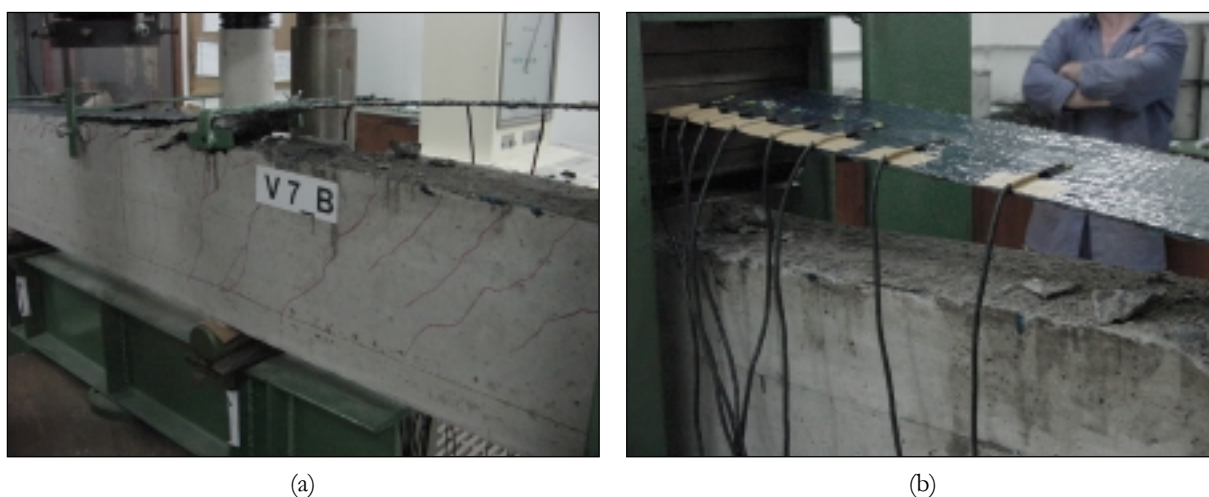
FIGURA 5-7 — Detalhe do modo de ruptura das vigas V7
