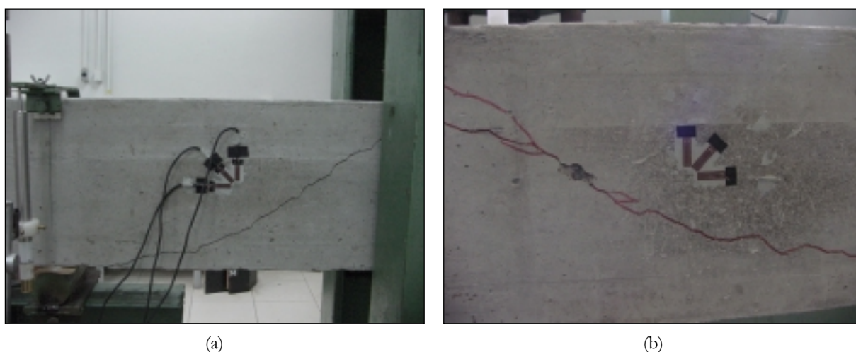
FIGURA 5-45 — Detalhe do modo de ruptura das vigas V8_A e V8_B
