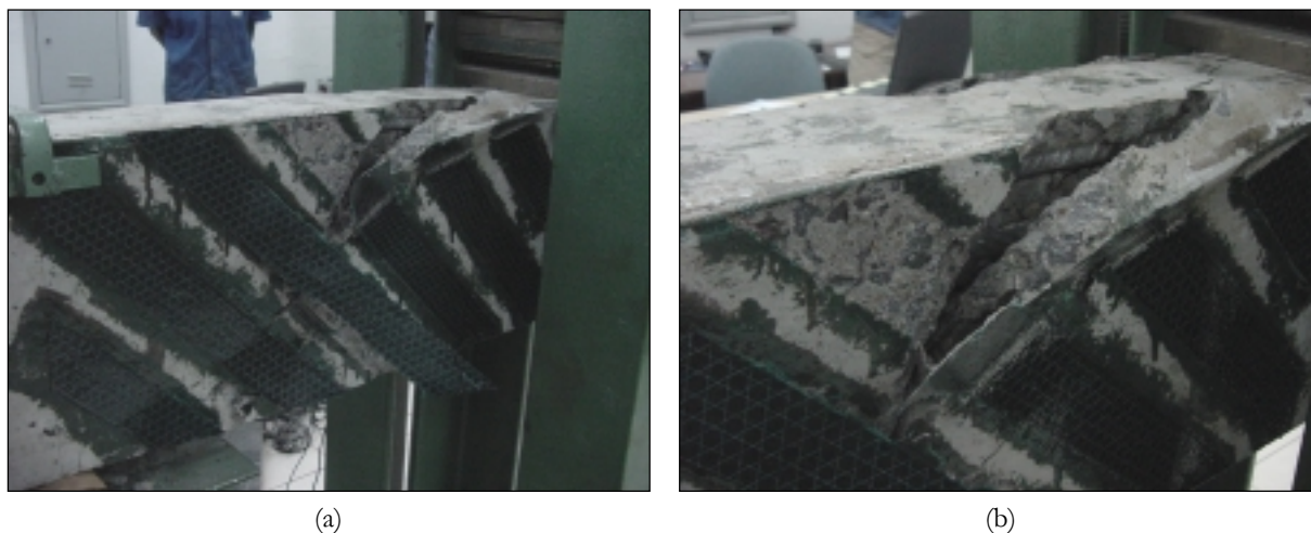
FIGURA 5-56 — Detalhe do modo de ruptura das vigas V12_B e V14_B
