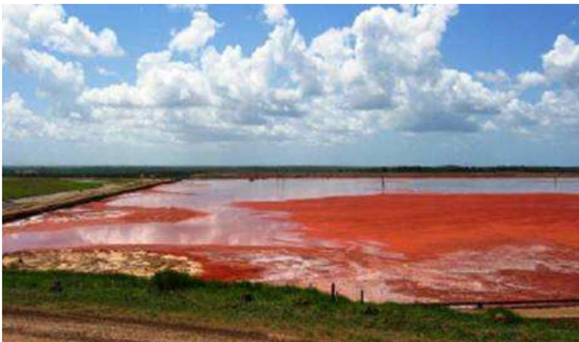
Figura 2: Foto do depósito de armazenamento de lamas vermelhas da refinaria ALUMAR, em São Luís – MA (BEDIN, 2008)
