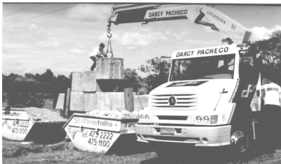
Figura 6.13 - Detalhe da montagem do sistema de reação.
