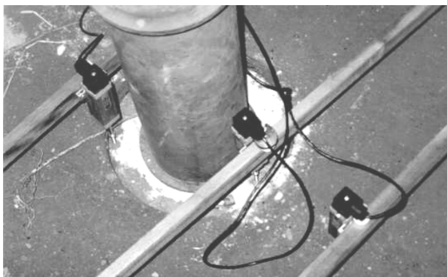
Figura 6.12 - Detalhe do sistema de medição dos deslocamentos.
