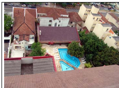
Fig. 38 – Vista superior do salão de festas e piscina coletiva do condomínio (16 jan. 2007)
