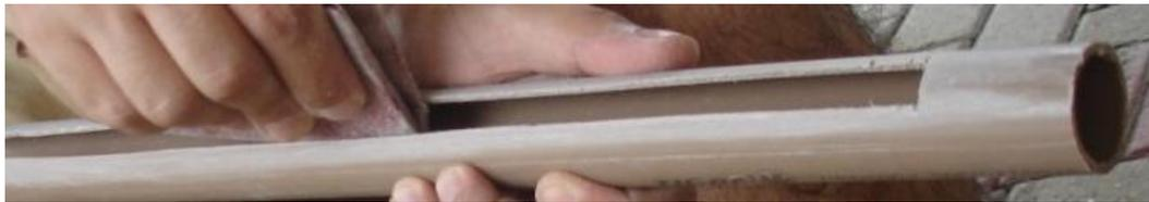
**Figura A24 – Lixando a abertura no tubo de PVC**
