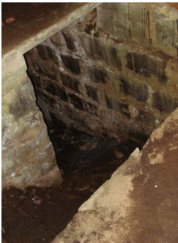
Figura 43: Escada . Fotografia, Ruínas do Cassino, Canela/RS, 2009.
