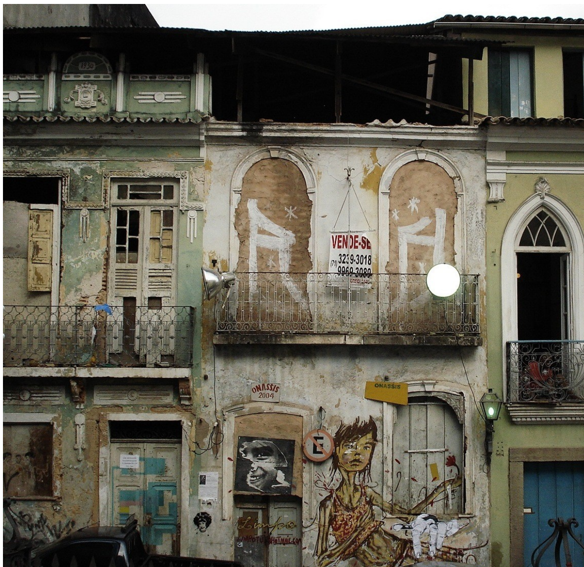
Figura 38: Intervenção e Fotografia, Salvador/BA, 2009.
