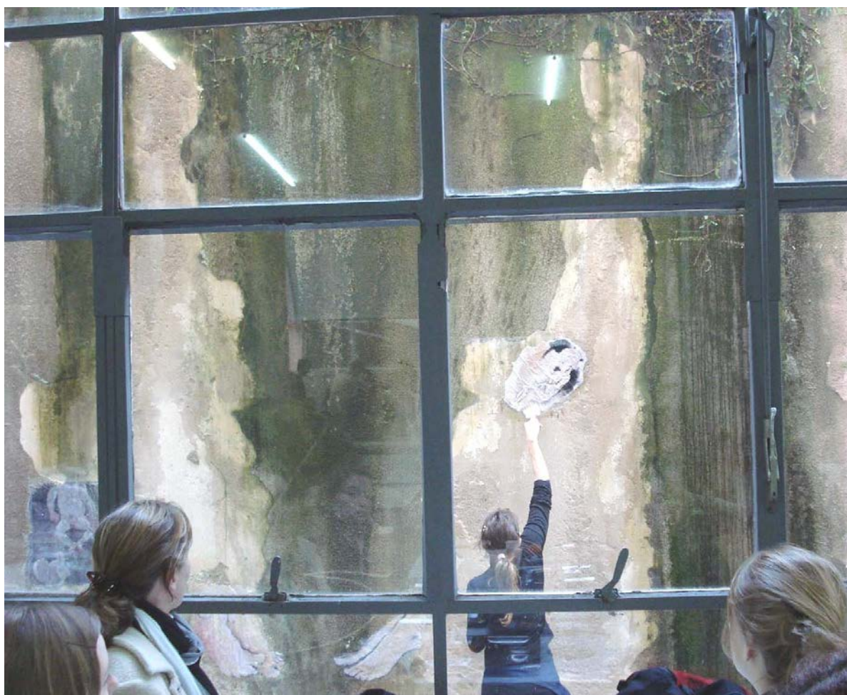
Figura 71: Registro do processo de intervenção, 2009.
