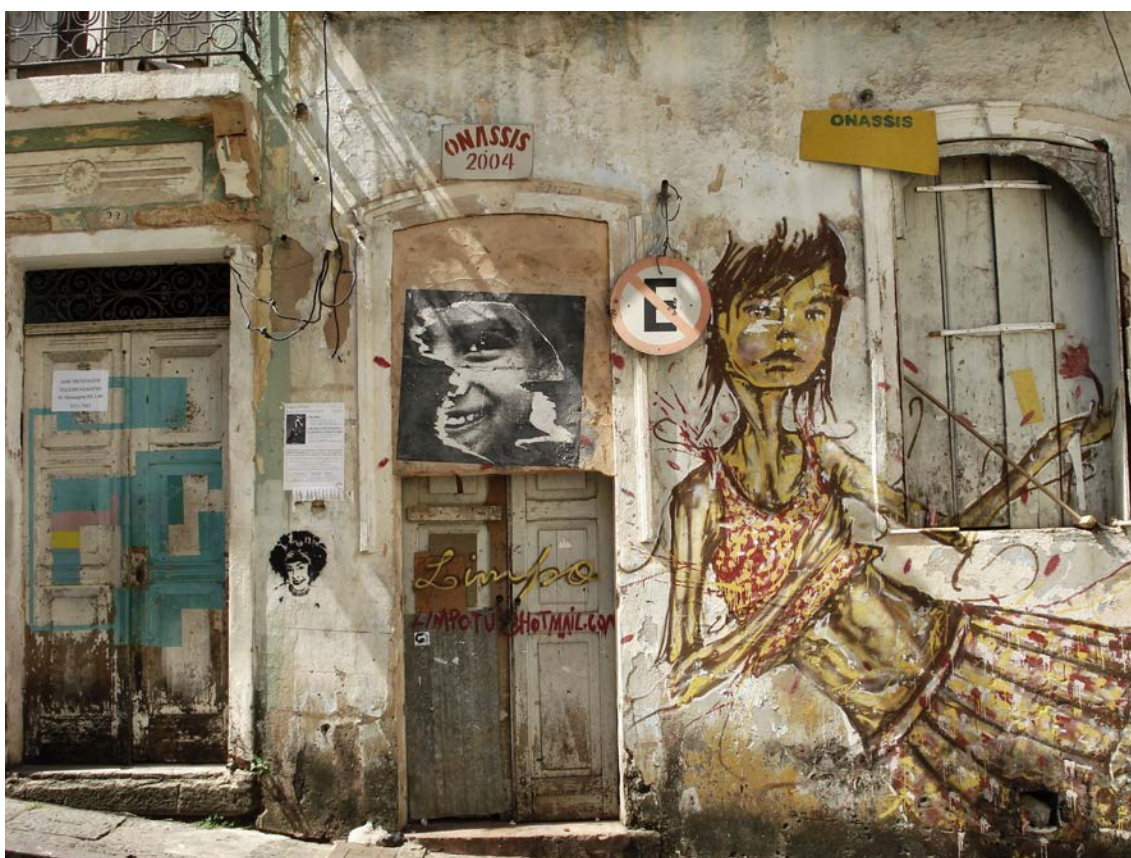
Figura 36: Registro para sondagem do lugar, 2009.
