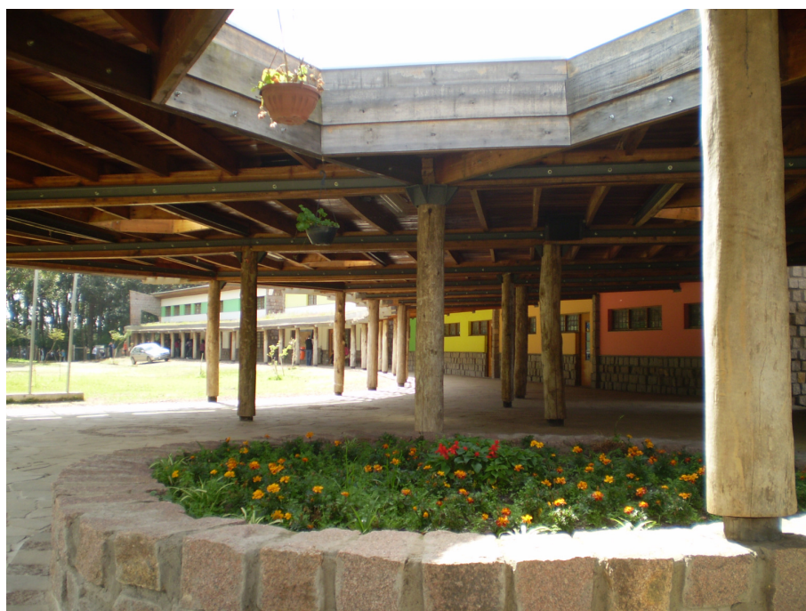
Figura 34: Abertura zenital na cobertura verde.
