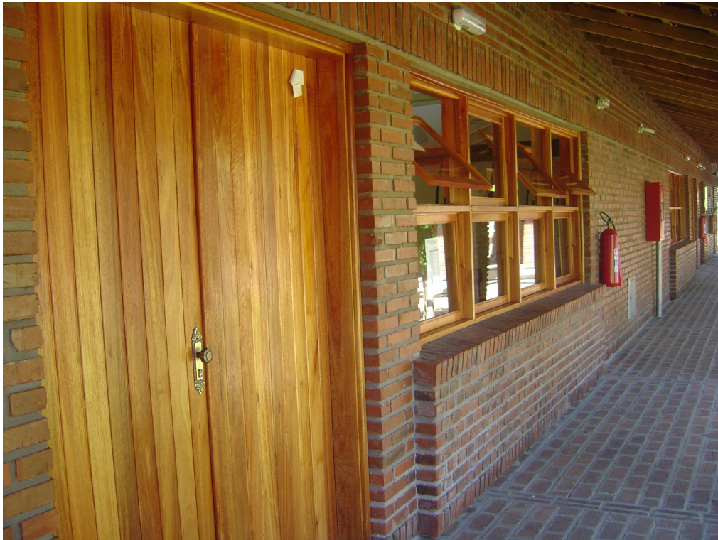
Figura 7: Vista dos materiais utilizados em paredes externas, piso externo e esquadrias.
