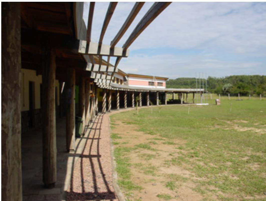
Figura 31: Galeria de circulação e leito de pedra, para escoamento pluvial.
