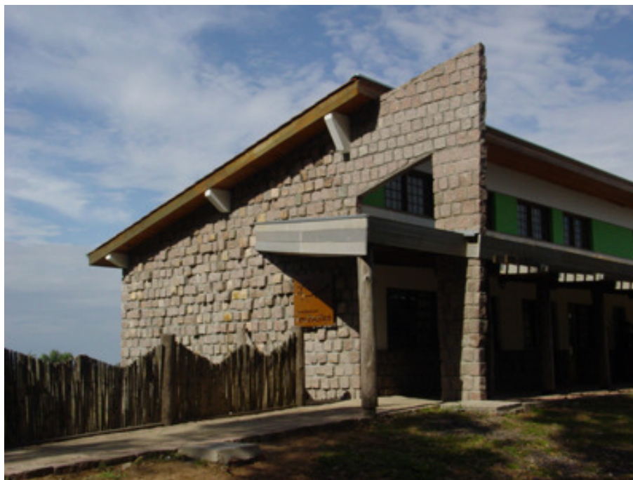
Figura 29: Pórtico de pedra construído na entrada da escola.
