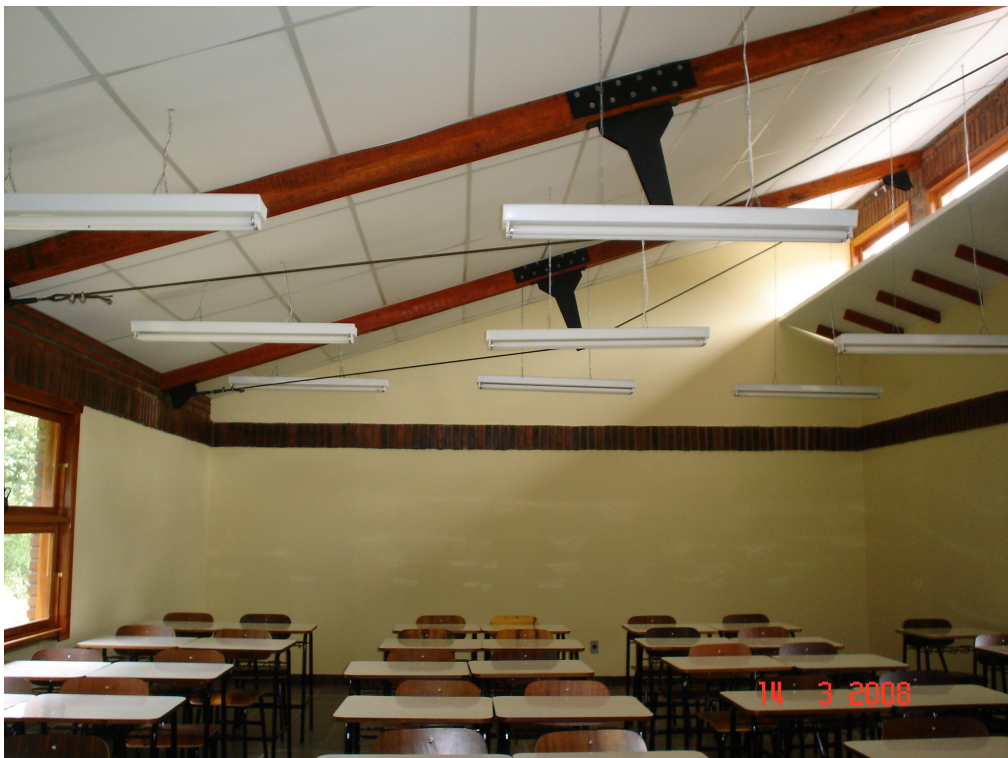
Figura 9: Ambiente interno de uma sala de aula, com detalhe da prateleira de luz.
