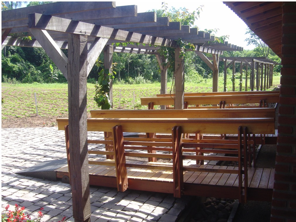
Figura 6: Vista de outro ângulo de uma das entradas principais da escola e dos materiais utilizados na construção.
