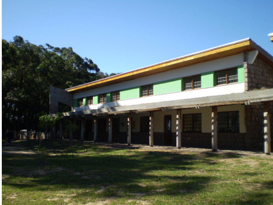
Figura 32: Vista do bloco 1.
