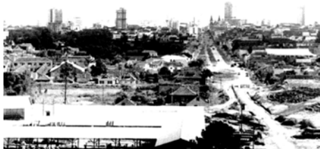
Curitiba – Av. Cândido de Abreu – 1950 – (CM) Vista do eixo em construção Não existia na época o Conjunto do Centro Cívico Vista para o centro da cidade Vê-se ao fundo as torres da Matriz
