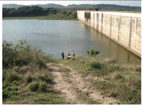
Figura 8. Barramento principal do reservatório de Tapacurá.
