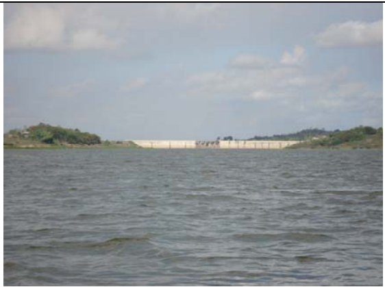
Figura 9. Vista do barramento principal do reservatório de Tapacurá.
