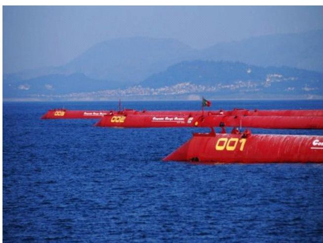
Figura 3.12: Parque offshore de energia de ondas com dispositivos Pelamis.
