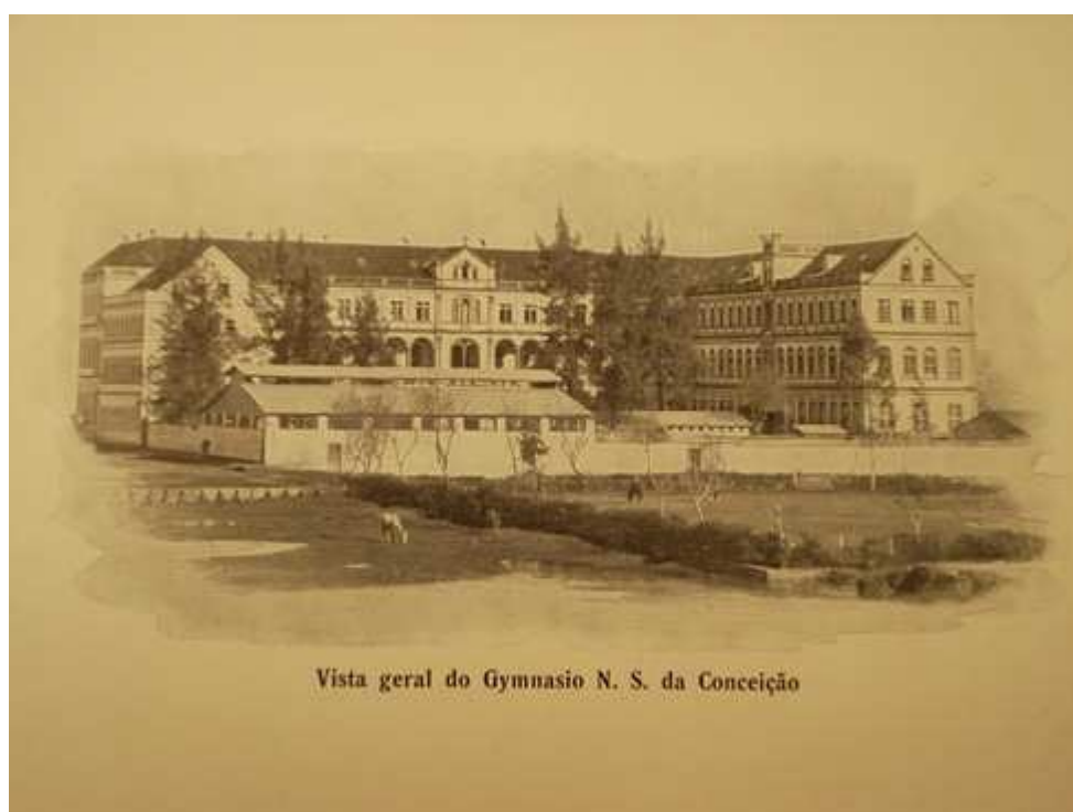
Figura 4 - Vista do Colégio Conceição (AHA AV)
