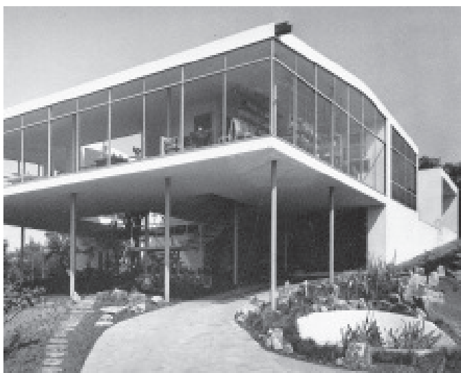
60. Casa de Vidro, Morumbi, São Paulo. Lina Bo Bardi, 1948-51. Coroamento: duas águas. LINA Bo Bardi , 1996, p. 79.
