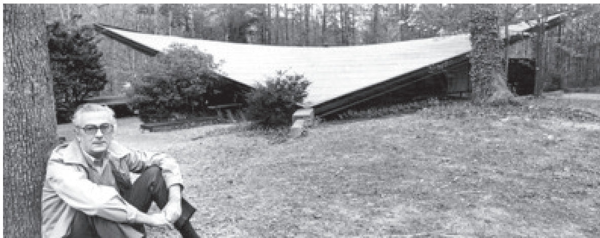
63. Casa Catalano, Raleigh, Carolina do Norte (EUA). Eduardo Catalano, 1953-55. Coroamento: parabolóide hiperbólico. http://www.trianglemodernisthouses.com/catalano.htm
