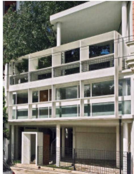
49. Casa Curutchet, La Plata, Argentina. Le Corbusier, 1949. Fachada multicamada total: grelha de concreto. 1:100: SELECCIÓN DE OBRAS, 2007, p. 13.
