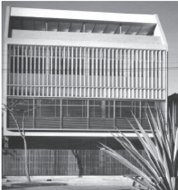
48. Casa Antônio Ceppas, Leblon, Rio de Janeiro (RJ). Jorge Machado Moreira, 1951-58. Fachada multicamada total: brises horizontais e verticais. CZAJKOWSKI, 1999, p. 55.
