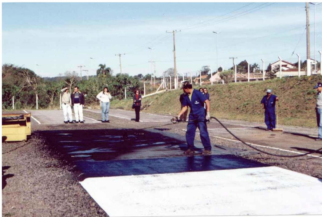
**FIGURA 3.17** - Pintura de ligação feita após o emprego das mantas de geotêxteis
