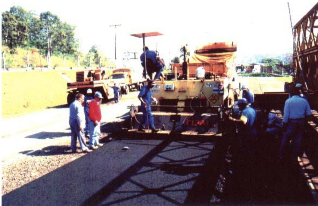
**FIGURA 3.9** – Execução da primeira camada de concreto asfáltico
