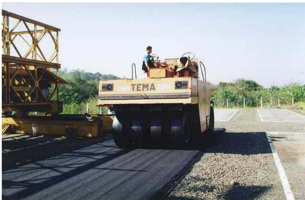
**FIGURA 3.10** – Compactação com rolo de pneus
