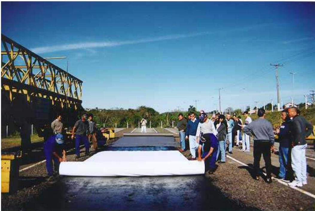
**FIGURA 3.15** – Emprego das mantas geotêxteis na pista experimental
