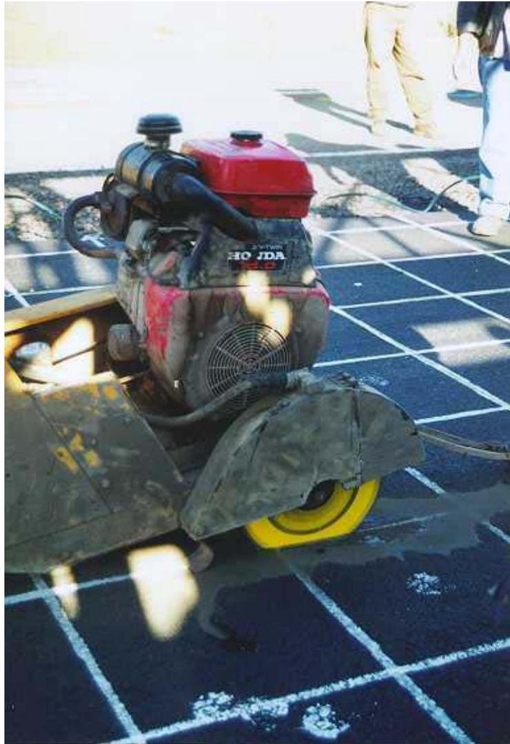
**FIGURA 3.13** – Execução das trincas com a serra
