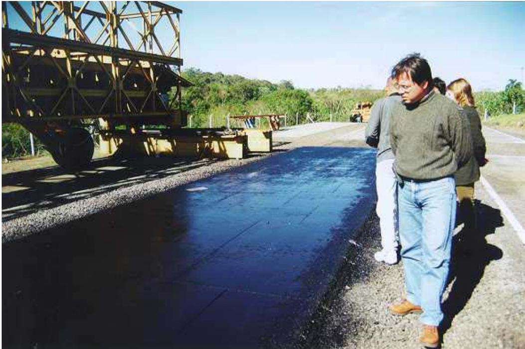
**FIGURA 3.14** – Pintura de ligação após a execução das trincas
