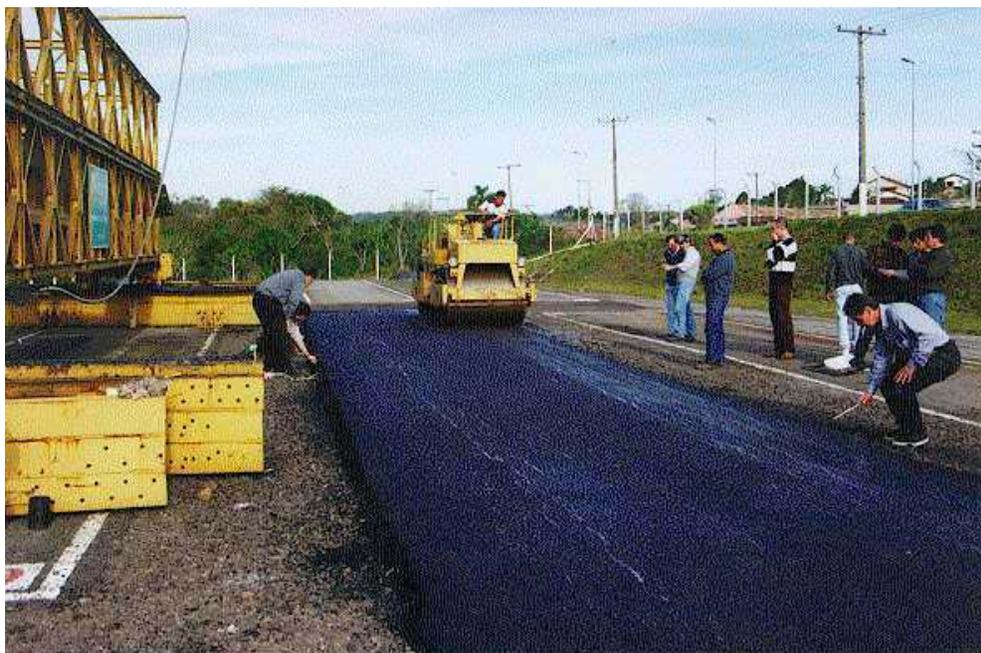
**FIGURA 3.18** – Execução da segunda camada de concreto asfáltico após o emprego das mantas de geotêxteis
