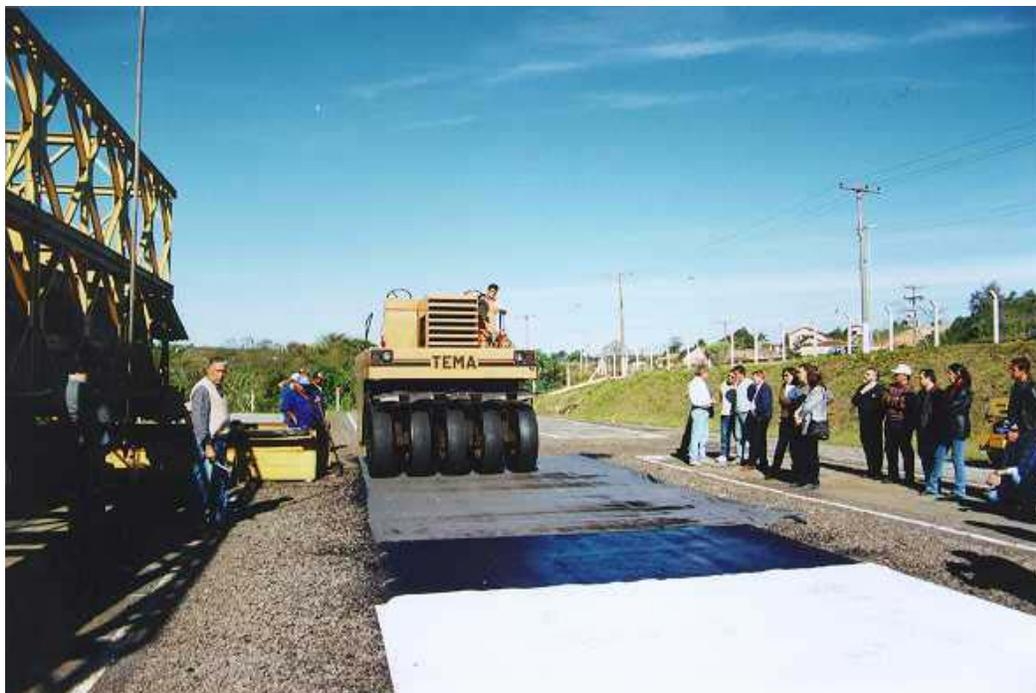
**FIGURA 3.16** – Compactação das mantas de geotêxteis
