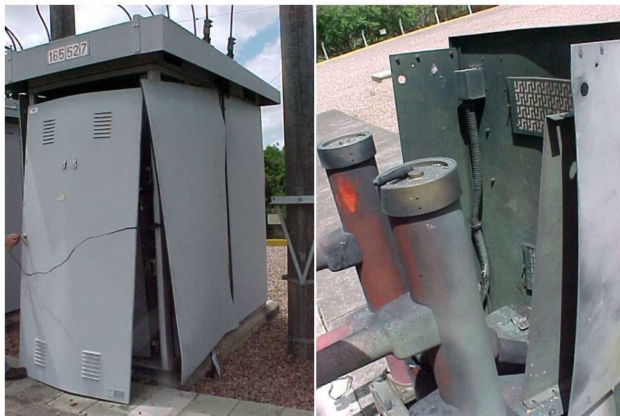
Figura 11: Disjuntores avariados [15].
