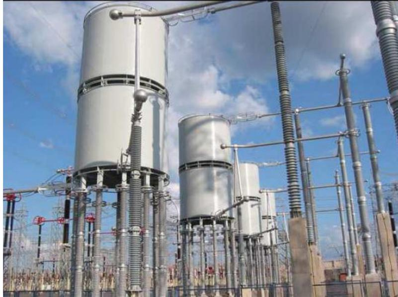
Figura 1: Reator limitador da estação de Tucuruí (LANES, 2006).
