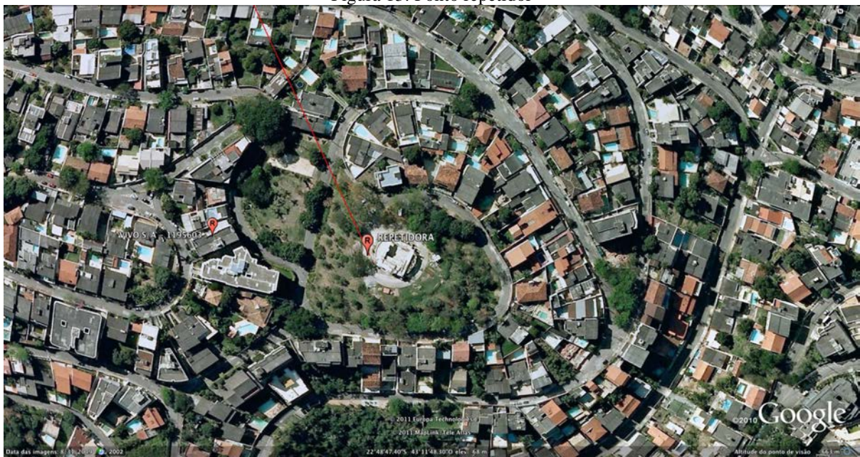
Figura 14: Estruturas verticais existentes
