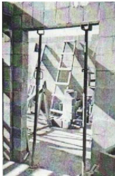
Figura 19: uso de escoras para apoiar os blocos-calha
