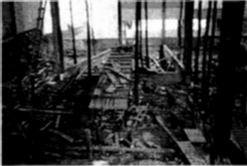
Figura 5.1. Prejuízos para a circulação e segurança na obra ocasionados pela execução de fôrmas no próprio canteiro.
