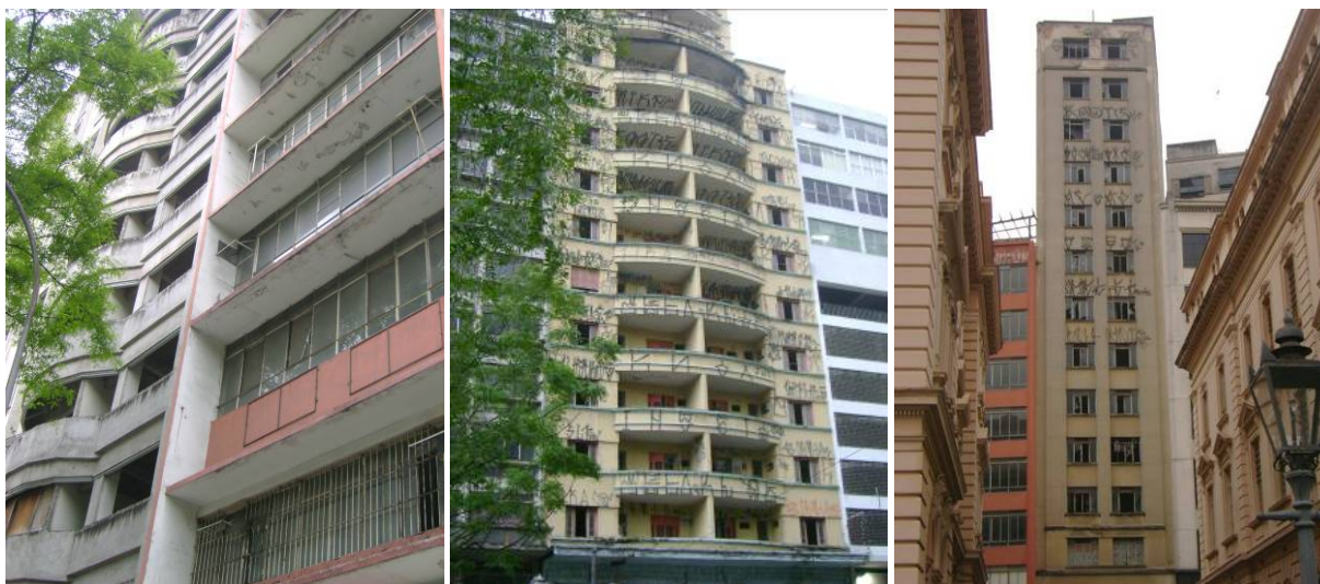
Figuras 7,8 e 9: Exemplos de prédios que perderam seu uso original no centro da cidade de São Paulo.
