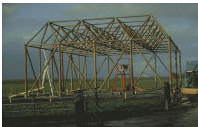
Fig. 3. Sistema estrutural com madeira roliça de diâmetro pequeno. Estudos realizados na Finlândia. Fonte: RANTA-MAUNUS,1999.
