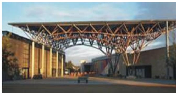
Fig. 4. Estrutura em madeira roliça a partir da combinação de poliedros. Feilden Clegg Bradley Architects. Doncaster, UK. Fonte: Carpenter Oak & Woodland Limited.
