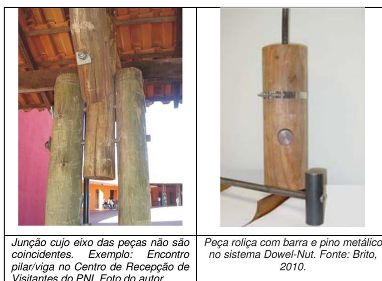
**Fig. 24. Exemplo de conexão com duplicação de peças e dowel-nut.**
