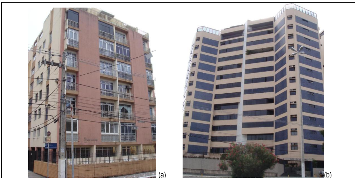
Figura 55. Edifícios Cidade Jardim (a) e Beira Mar (b)
