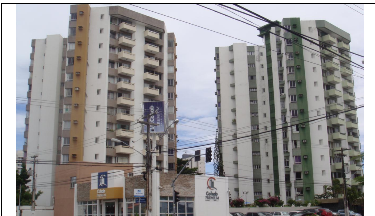
Figura 56. Condomínio Villa D'Oro
