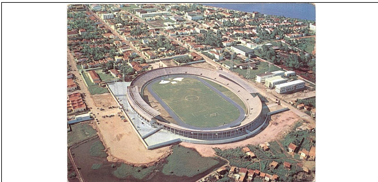
Figura 10. Vista do “Batistão” para o Bairro São José
