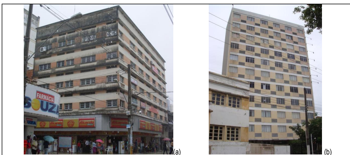
Figura 54. Edifícios Mayara (a) e Atalaia (b)
